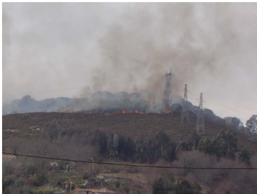
Fig. 4.1.8 – Fotografia de um incêndio sob uma linha de transporte [Fonte:REN]
