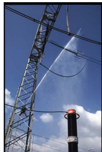
Fig.4.2.2.1 – Lavagem em tensão
