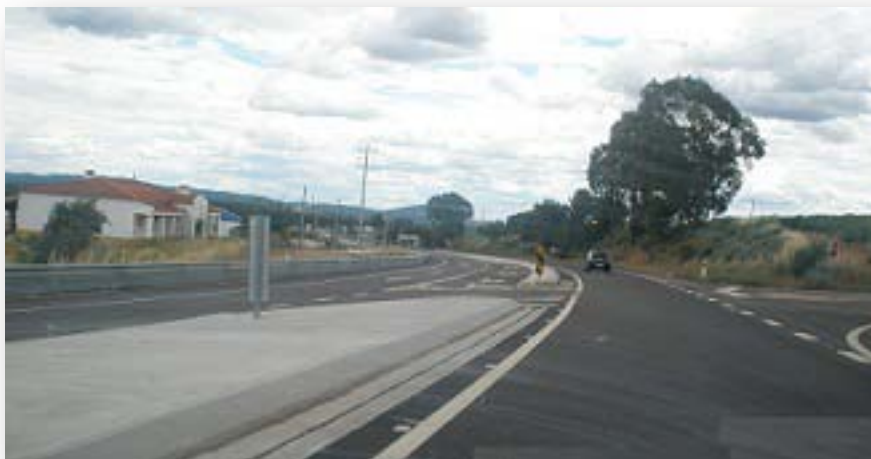
Figura 49 – Via exclusiva para viragem à esquerda materializada, na estrada N118 (fotografia tirada pelo autor para este trabalho).
