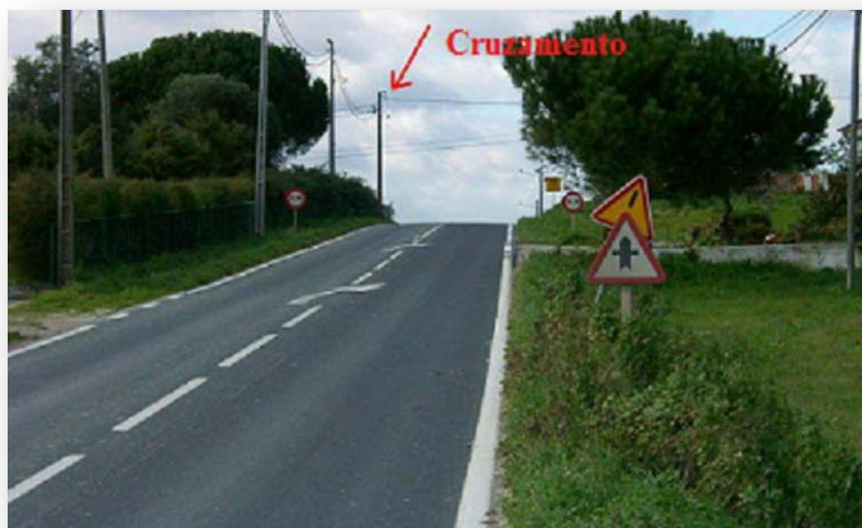
Figura 36 - Restrição de visibilidade devido a uma concordância convexa, na estrada N114 (Fotografia tirada pelo autor para este trabalho).
