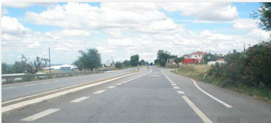
Figura 45 – Via de desaceleração para viragens à direita na estrada N4 (fotografia tirada pelo autor para este trabalho).
