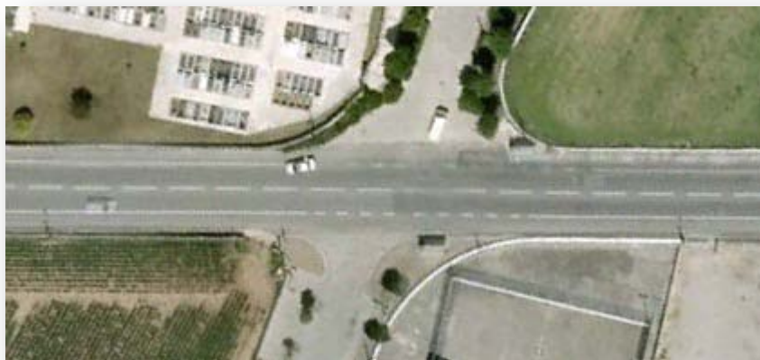
Figura 20 – Cruzamento na estrada N13 sem canalização de tráfego (imagem de satélite extraída do Google Earth para este trabalho).
