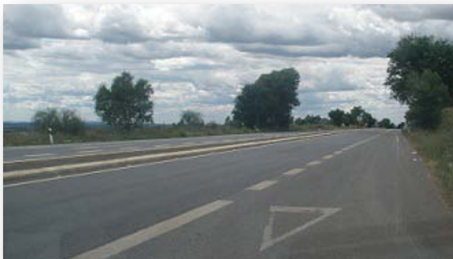
Figura 53 – Via de aceleração do tipo paralelo na estrada N4 em faixa de rodagem de 2x1 vias (fotografia tirada pelo autor para este trabalho).
