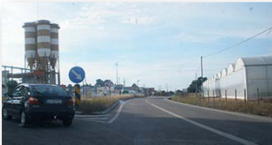
Figura 54 – Via de aceleração na estrada IC2 com faixa de rodagem de 2x1 vias (fotografia tirada pelo autor para este trabalho).
