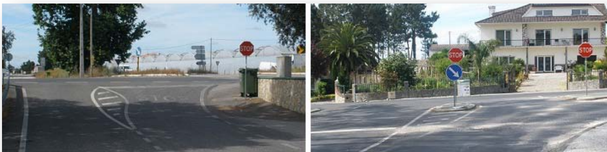
Figura 15 – Intersecções prioritárias com diferentes graus de canalização (fotografia tirada pelo autor para este trabalho).
