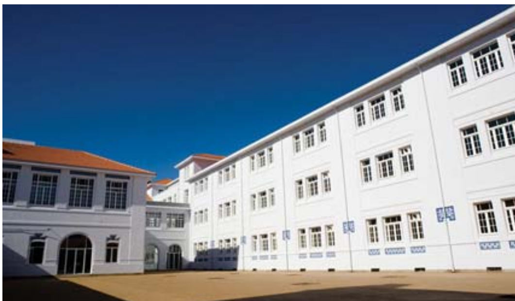
Figura 6.7 – Recreio da Escola Secundária Rodrigues de Freitas [67]
