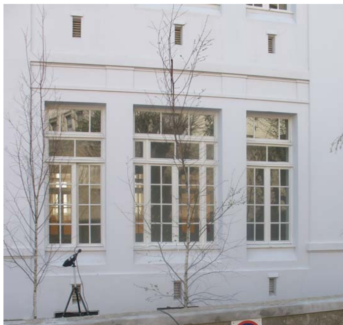
Figura 7.18 – Fachada da Escola Secundária Rodrigues de Freitas [fotografia da autora]
