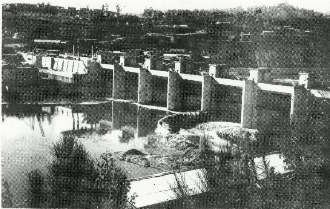
Fig. 1 - Aspecto das obras de construção da barragem de Crestuma/Lever.
