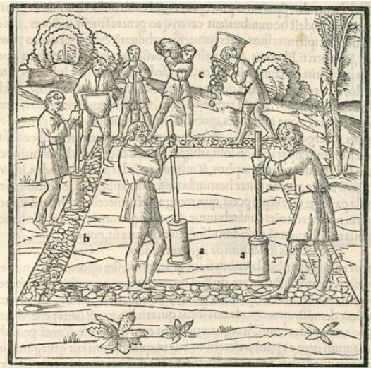
Fig. 6 - Processo de construção de uma cisterna. Calcamento com maços de madeira (a) da argamassa (b) e o despejamento da pedra móida (c) (VITRÚVIO - M. Vitruvius per locundum solito castigatior factus cum figuris et tabula ut iam legi et intellegi possit. Transcrição e gravuras de Fra Giocondo. Venesa: Giovanni da Tridentino, 1511. fl. 83).
