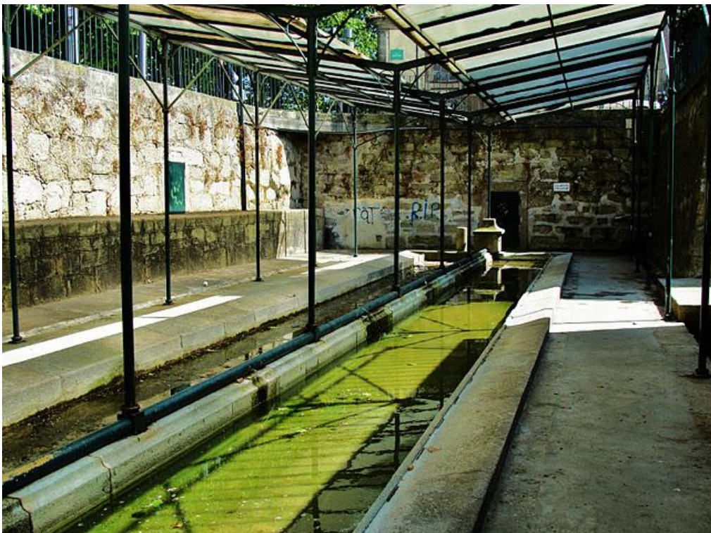
Fig. 61 - Lavadouros da Arca d'Água de Paranhos.
