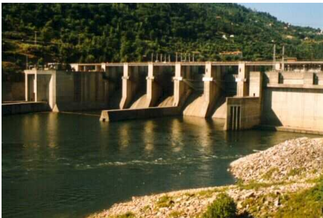
Fig. 8: Barragem do Carrapatelo.
