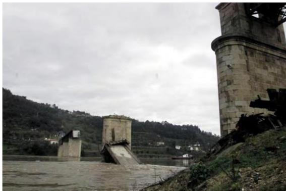
Fig. 1.2 – Ponte de Entre-os-Rios após a queda
