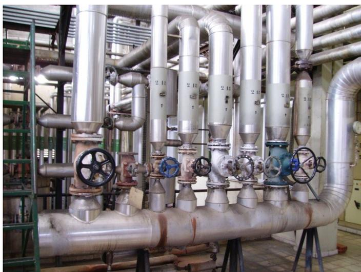
**Figura 29 – Colector de vapor.**
