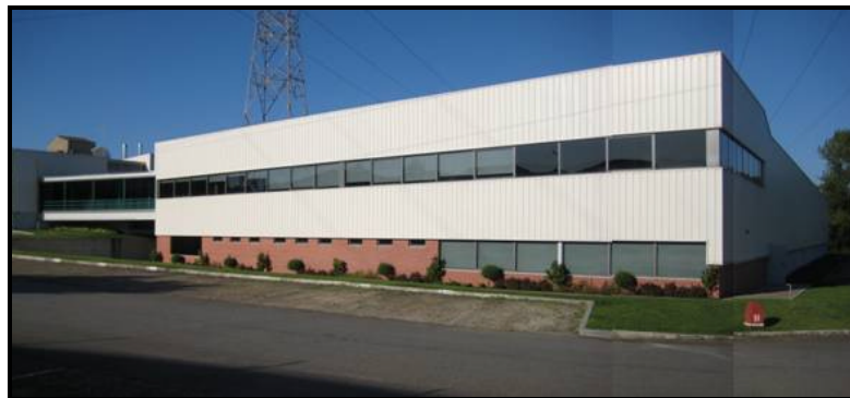
Figura 1.8 – Aspecto exterior do pavilhão fabril da ZCP–Alumínio.
