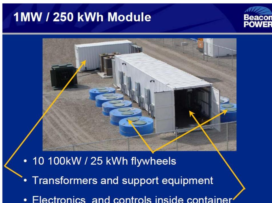
Figura 2.10 - Modelo da estrutura de funcionamento de um módulo de 250 kWh / 1 MW (15min) [27].
