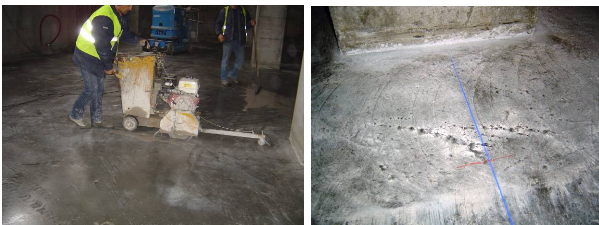
Fig.5.30 – Serragem das juntas.
