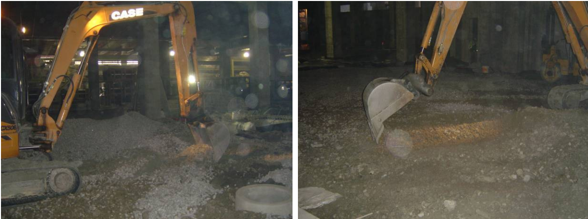
Fig.5.16 – Esquerda: Pá carregadora a despejar o material britado no local; Direita: Regularização do material despejado.
