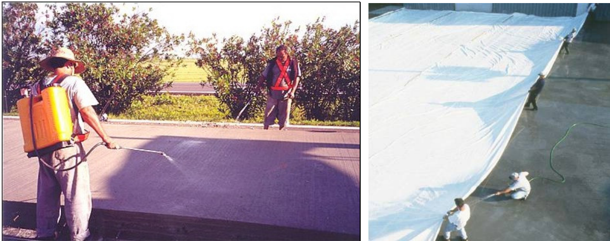
Fig.2.36 – Esquerda: Cura química ( http://www.solucoesparacidades.com.br/passeio_publico/whitetopping-passo-a-passo ); Direita: Cura húmida ( http://www.consultoriaeanalise.com/search?updated-max=2011-05-17T22%3A30%3A00-03%3A00&max-results=10 ).
