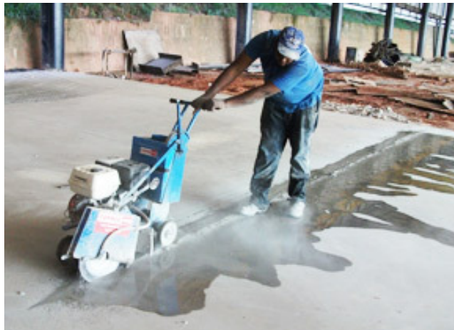
Fig.2.37 – Execução de juntas serradas ( www.jmpisosindustriais.com.br ).
