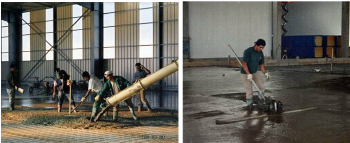
Fig.3.11 – Esquerda: Lançamento do betão; Direita: Regularização com régua vibratória ( www.servipavi.net ).
