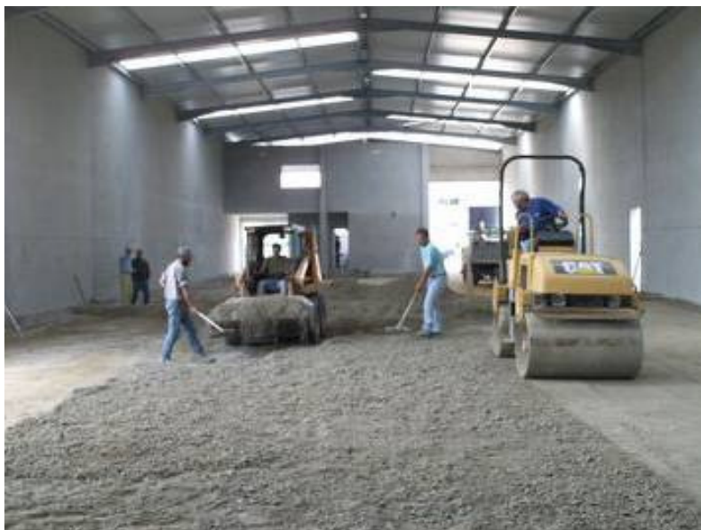
Fig.3.9 – Execução de trabalhos de compactação de pavimentos ( www.pavimaia.pai.pt ).
