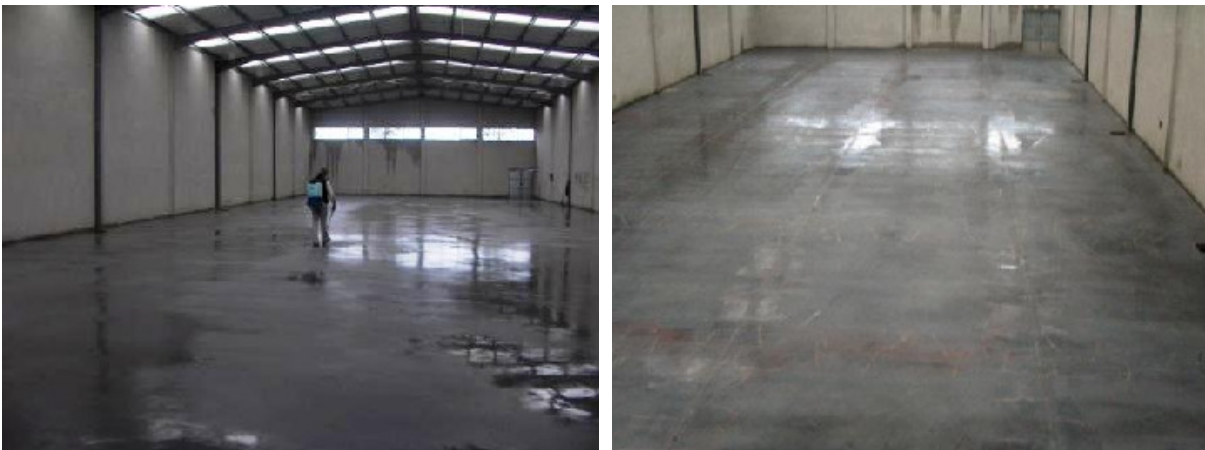
Fig.3.2 – Cura do betão ( www.pavin.net ).
