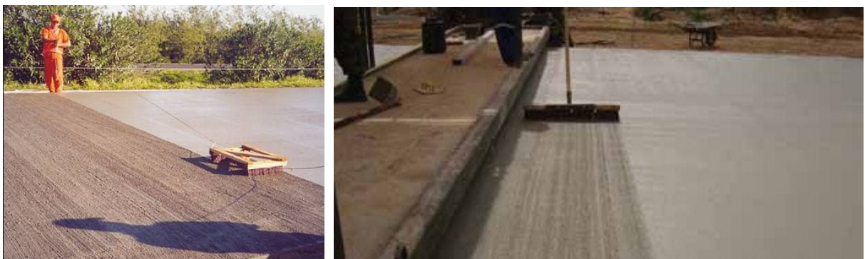
Fig.2.14 – Texturização mecânica (Esquerda: www.pisosindustriais.com.br ; Direita: www.solucoesparacidades.com.br ).
