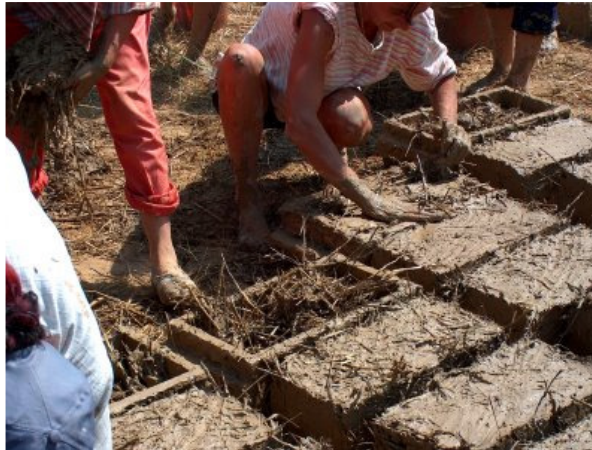
Fig.2.1 – Execução de tijolos com fibras ( http://resgateanatureza.blogspot.com/2011/04/tijolo-natural.html ).
