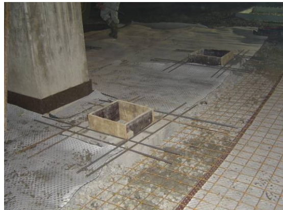
Fig.5.19 – Exemplo de pormenor de reforço auxiliar em torno de uma caixa.
