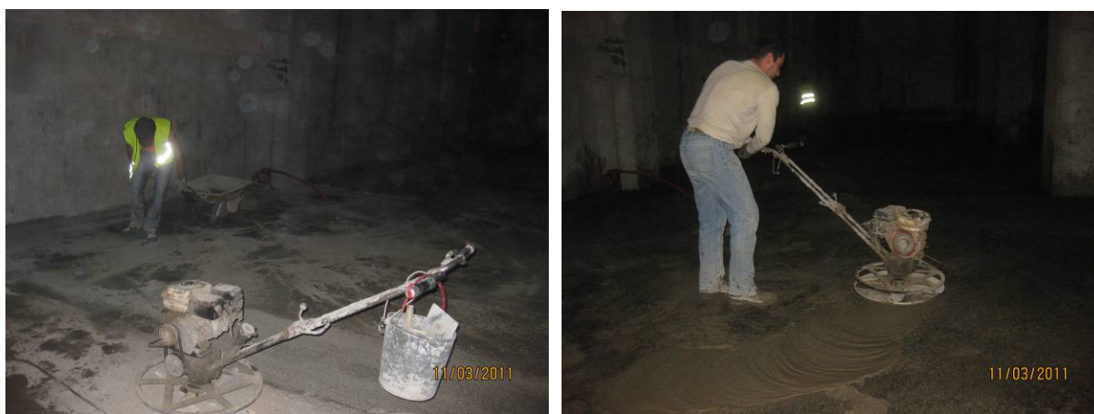
Fig.5.26 – Aspersão dos agregados e posterior passagem do «helicóptero».
