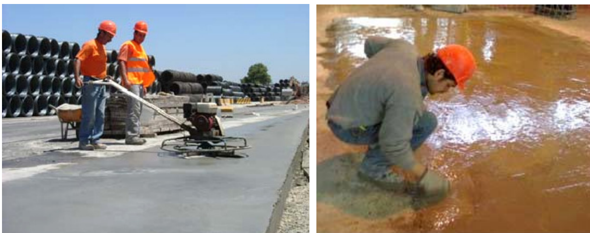
Fig.3.13 – Esquerda: Alisamento da superfície com «helicóptero»; Direita: Recuperação de um pavimento ( www.egon.pt ).
