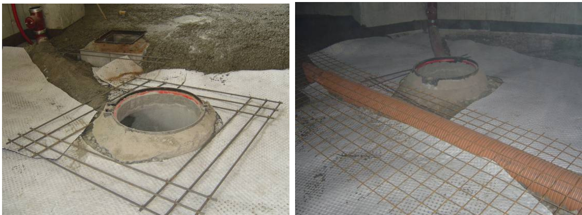
Fig.5.20 – Aplicação de armadura de reforço.
