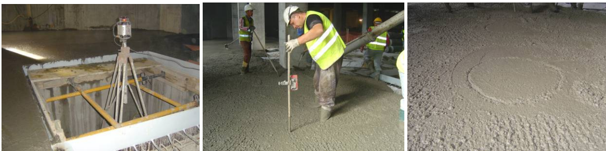
Fig.5.25 – Utilização de um laser emissor rotativo para controlo da espessura de betão.
