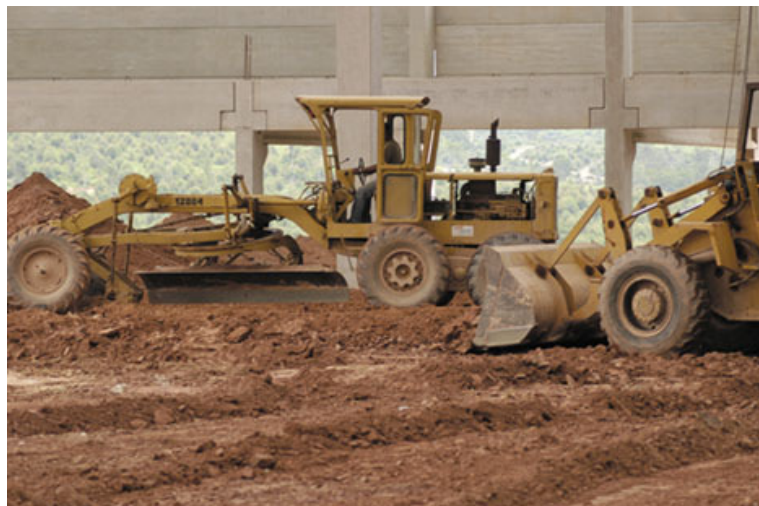
Fig.2.10 – Preparação de um solo ( http://www.revistatechne.com.br/engenharia-civil/163/artigo189448-1.asp ).
