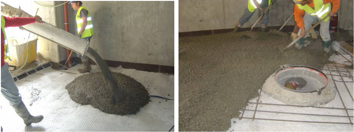
Fig.5.23 – Lançamento e espalhamento do betão.
