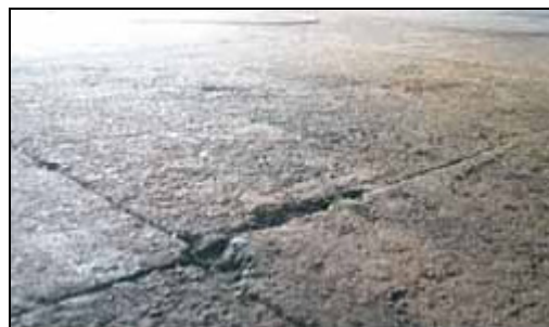
Fig.2.41 – Desgaste do pavimento ( http://www.pisosindustriais.com.br/materias/noticia.asp?ID=165 ).
