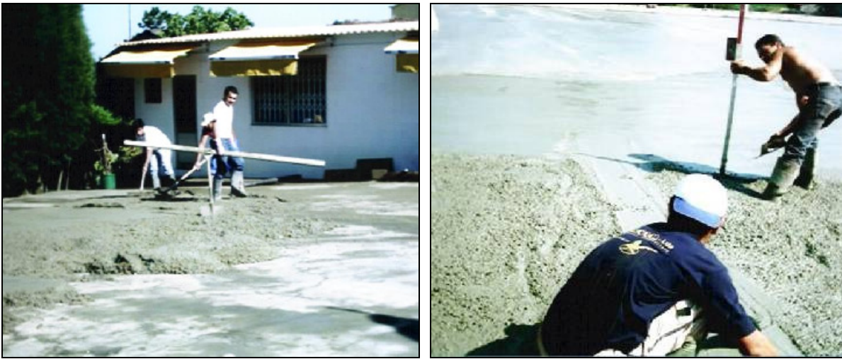
Fig.3.1. – Esquerda: Espalhamento; Direita: Nivelamento do betão ( www.pavin.net ).
