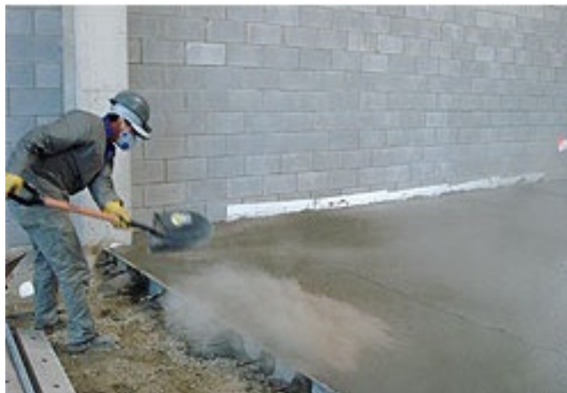
Fig.2.15 – Aspersão do endurecedor de superfície ( www.revistatechne.com.br ).
