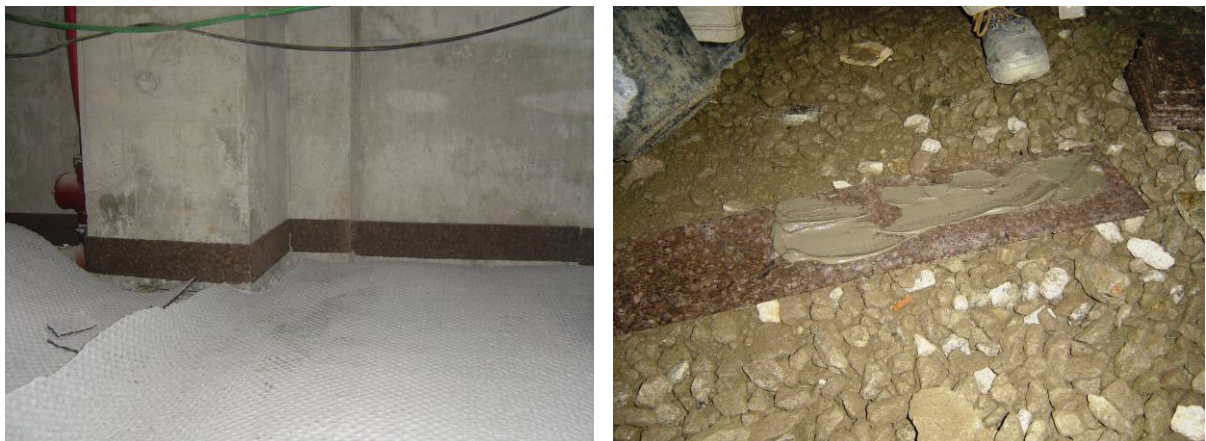
Fig.5.28 – Colagem do aglomerado de cortiça nos elementos a separar.
