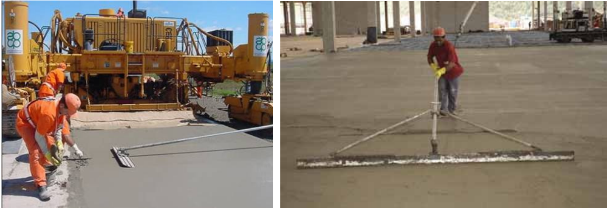
Fig.2.34 – Esquerda: Talochamento ( www.solucoesparacidades.com.br ); Direita: Sarrafeamento ( www.pisosindustriais.com.br ).
