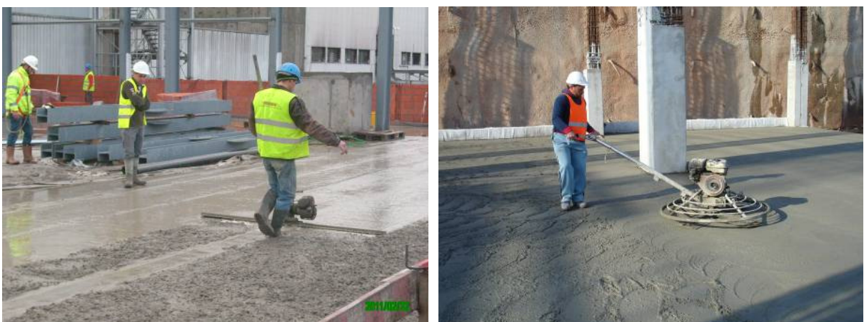
Fig.2.35 – Esquerda: Utilização de régua vibratória; Direita: Utilização de um «helicóptero» ( www.pavieste.pt ).
