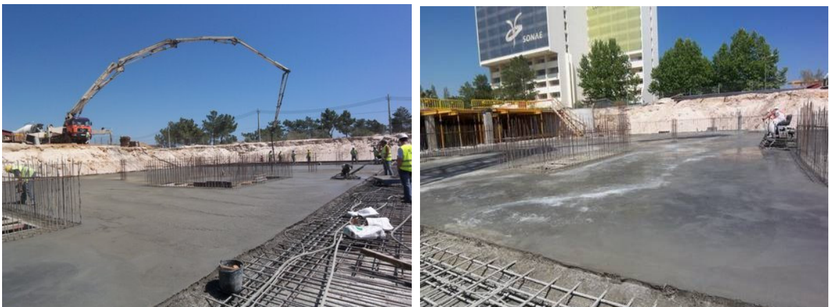
Fig.3.10 – Execução de pavimentos industriais ( www.solpave.com ).
