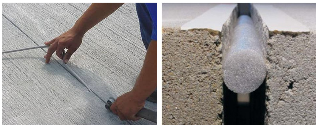
Fig.2.38 – Limitador de profundidade do selante para juntas serradas (fundo de junta) (Esquerda: www.solucoesparacidades.com.br ; Direita: Cristelli, 2010).
