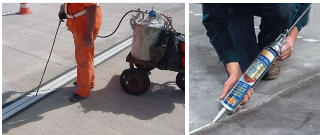
Fig.2.39 – Selagem de juntas ( www.solucoesparacidades.com.br ).
