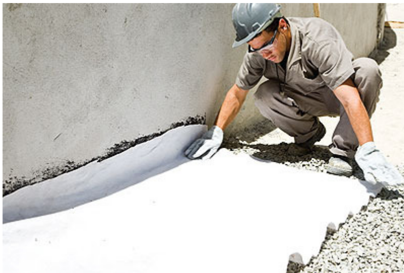
Fig.5.4 – Rolo de geotêxtil ( http://www.equipededeobra.com.br/construcao-reforma/22/imprime129440.asp ).
