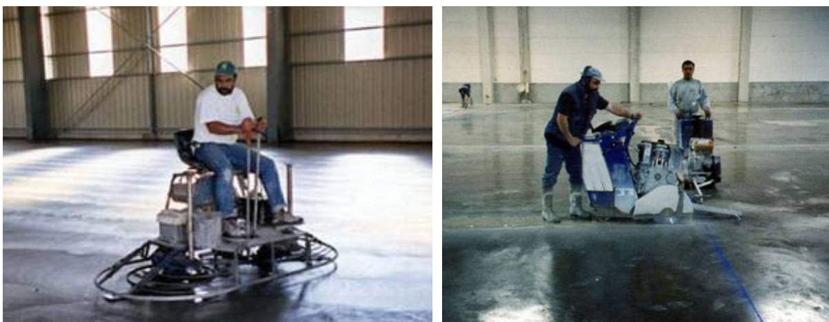
Fig.3.12 – Esquerda: Alisamento da superfície com «hélicóptero»; Direita: Serragem de juntas ( www.servipavi.net ).
