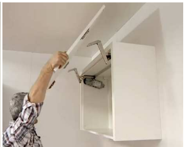
Figura 4: Colocação da porta em funcionamento
