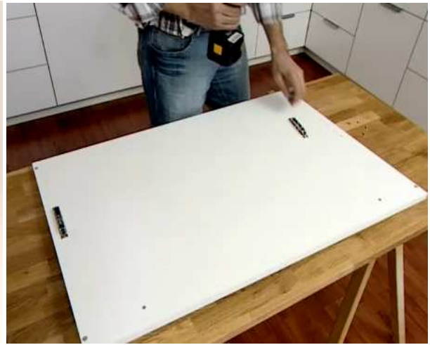
Figura 2: Aplicação dos engates nas portas
