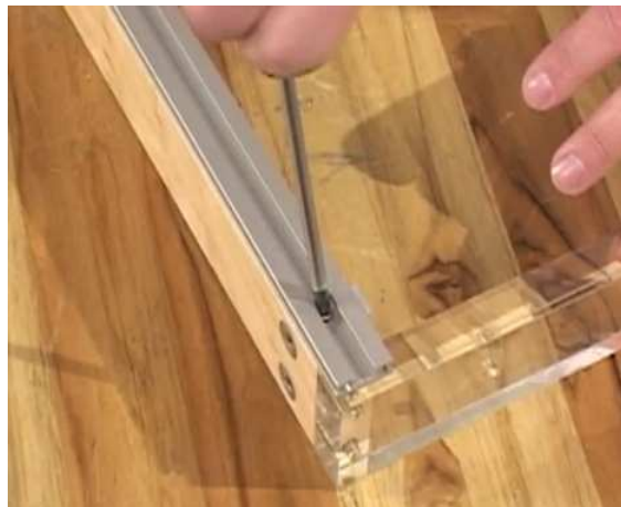
Figura 3: Instalação das calhas
