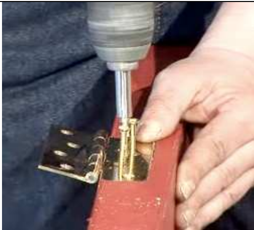
Figura 3: Fixação das dobradiças na porta
