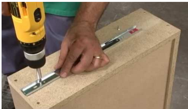
Figura 1: instalação da corrediça na lateral da gaveta
