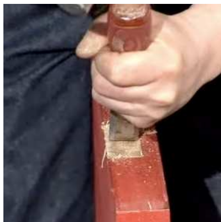
Figura 2: Execução das reentrâncias
