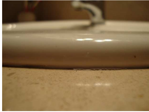
Fig.3.33 – Ligação banca ou lavatório / tampo
