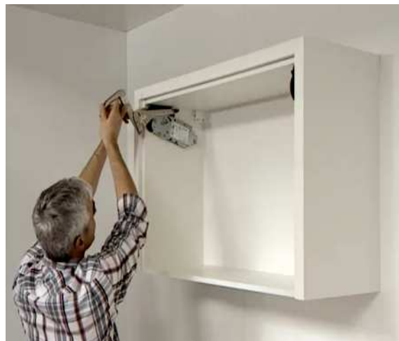
Figura 3: Instalação dos compassos
