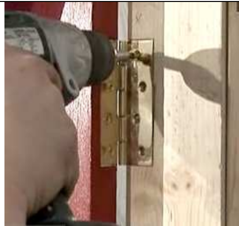
Figura 4: Fixação das dobradiças ao corpo do móvel
