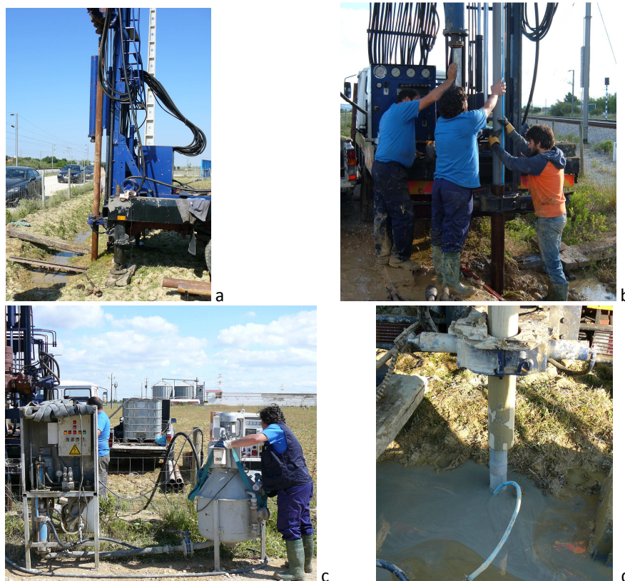
Figura 8.9 – Preparação dos furos para realização do ensaio Cross-hole: a) furação do terreno; b) introdução do revestimento em PVC e do tubo de injeção; c) equipamento de fabrico e injeção de calda; d) injeção de calda de cimento e retirada do revestimento provisório.
