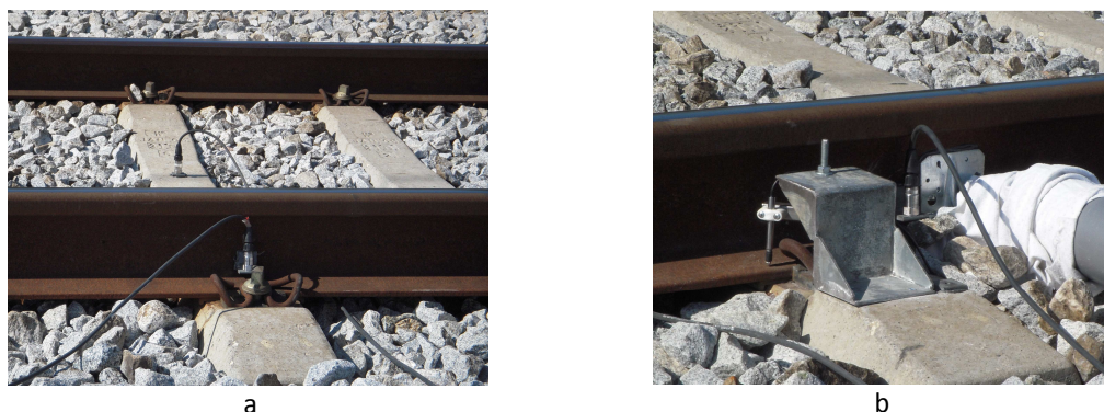
Figura 8.32 – Instrumentação da via férrea: a) acelerómetros colados no carril e travessa; b) posicionamento do LVDT.
