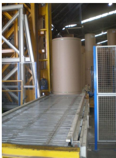
Figura 79 – Conveyors de descarga final de bobines (cortesia da Europac Kraft Viana)
