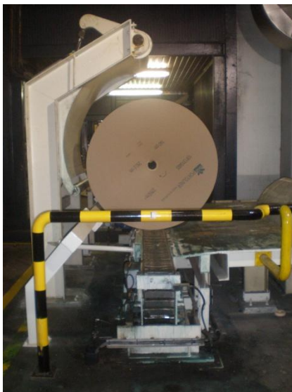
Figura 75 – Conveyor de recepção de bobines ( cortesia da Europac Kraft Viana )
