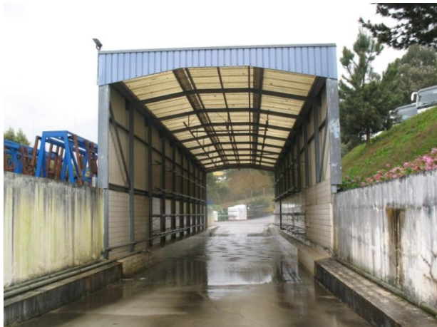
Figura 30 - Túnel de água.
