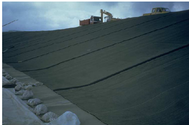
Figura 1.6 – Exemplo da aplicação de geossintéticos com função de protecção em taludes de aterros de resíduos (Lopes, 2005).
