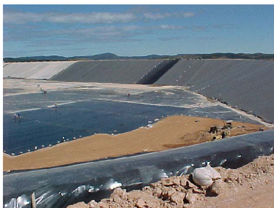
Figura 1.9 – Aterro de resíduos de bauxite: impermeabilização em construção.
