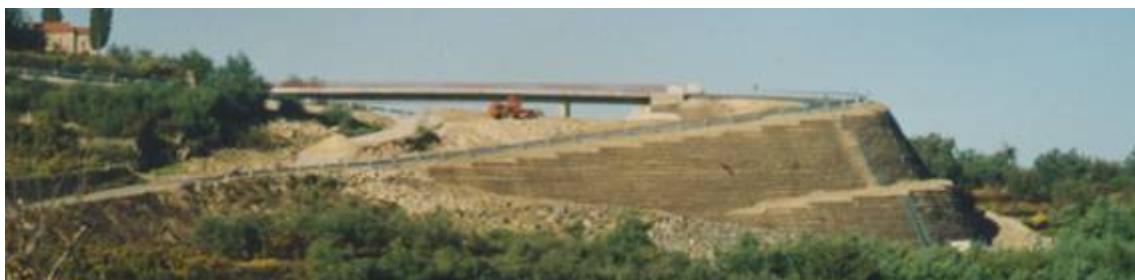
Figura 4.1 – Aterro reforçado no troço Régua/Reconcos do IP3 (Lopes e Mendonça, 1998).
