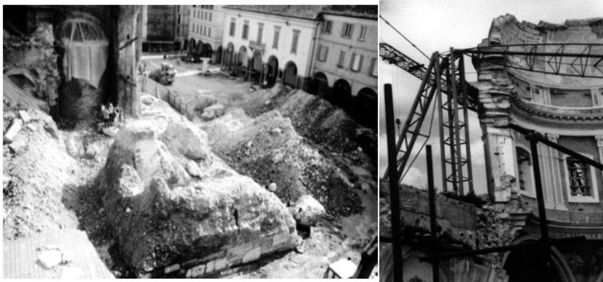
Fig. 2.4 – Casos com necessidade de investigação para a relação causa – efeito ficar explícita, à esquerda a torre do sino de Pavia depois do seu colapso e à direita escombros da catedral de Noto em Siracusa ( http://www.arcchip.cz/w11/w11_binda.pdf ).
