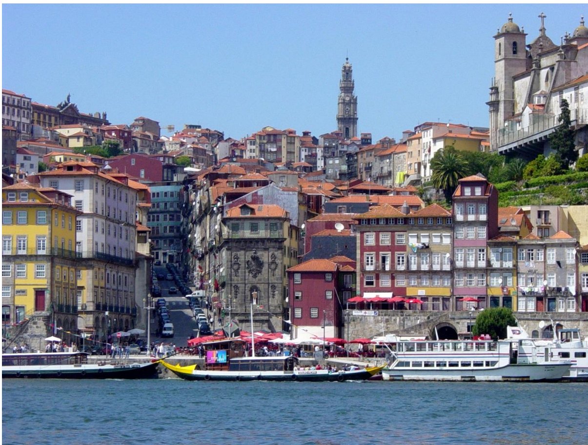
Fig.2.2 – Exemplos de alvenarias de pedra na cidade do Porto
