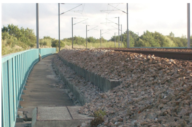
Figura 3.5 – Ponte de Canelas, vista da via (foto do autor)
