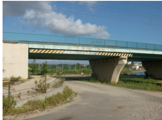
Figura 3.2 – Ponte de Canelas, tramo Norte (foto do autor)
