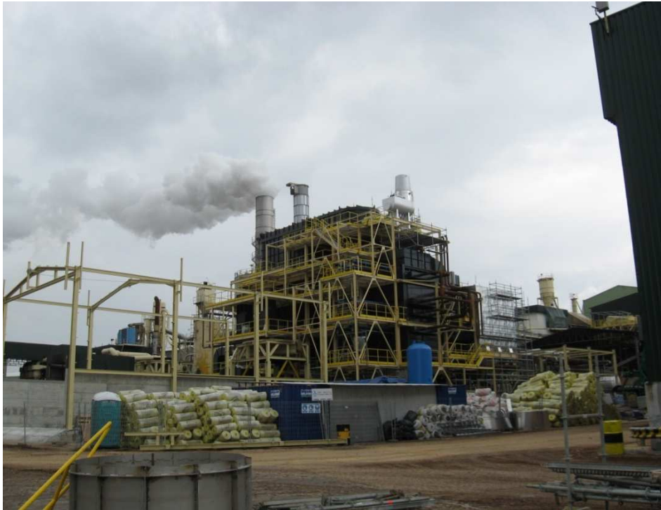
Figura 5 - Ilustração da chaminé da caldeira (C) em Oliveira do Hospital.
