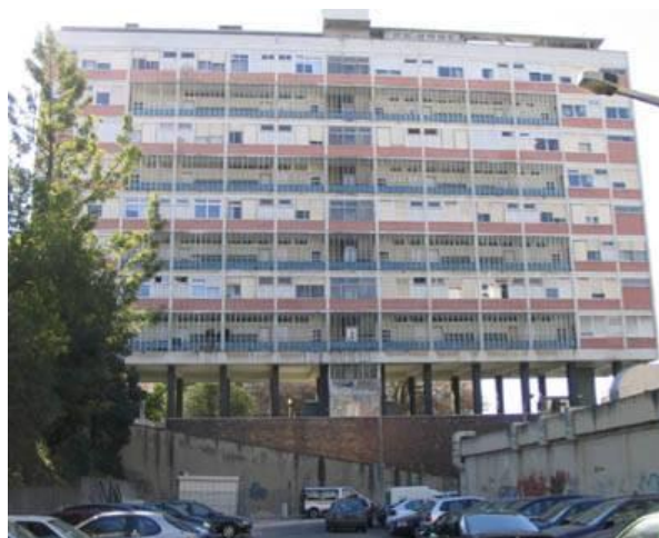
Fig.3.7 – Foto do edifício da avenida Infante Santo
