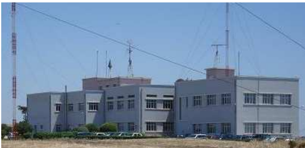
Figura 6.3 - Instalações da ANACOM.
