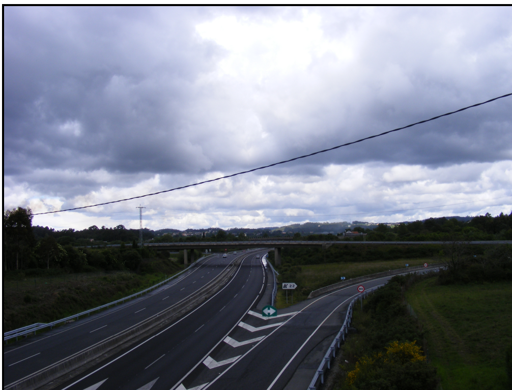
Figura 14.17- Vista da AG-55
