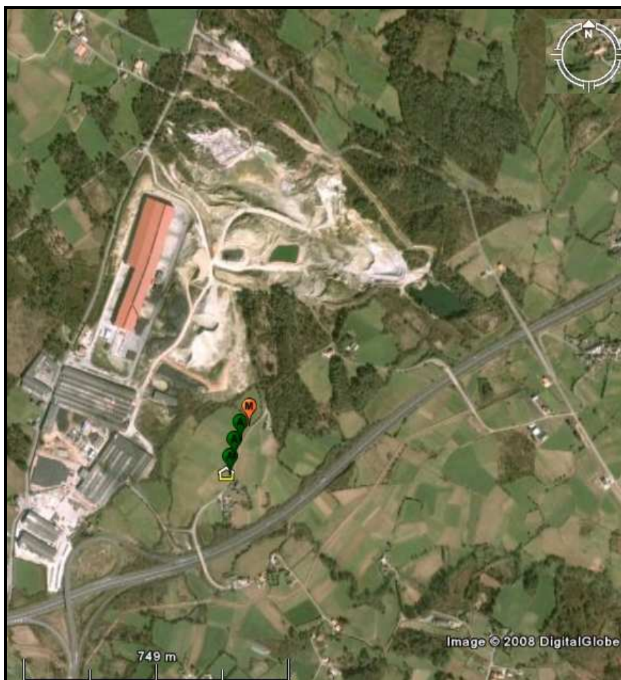
Figura 14.6- Vista geral do parque mini eólico (2D) [10]
