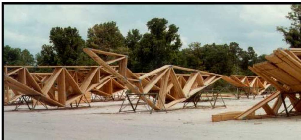
**Figura 4.14. – Armazenamento de estruturas articuladas planas antes da montagem da estrutura**
