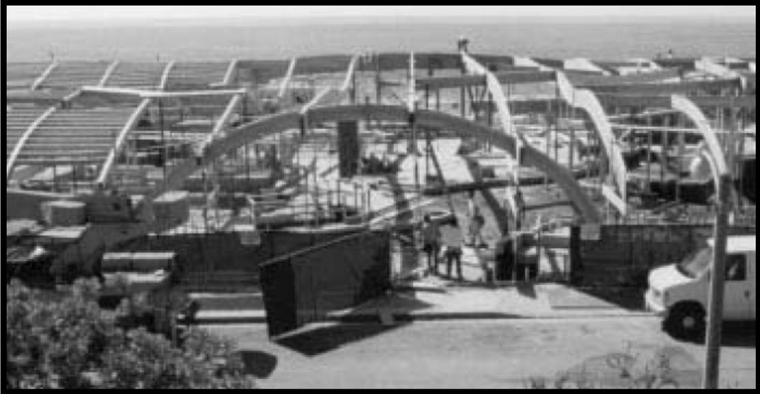
**Figura 3.4 – Exemplos de edifício com várias vigas curvas**
