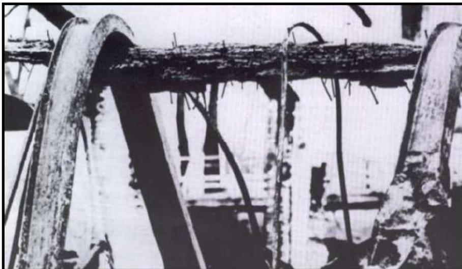
**Figura 4.10 – Vigas de aço deformadas pela acção do fogo sobre viga de GLULAM carbonizada**
