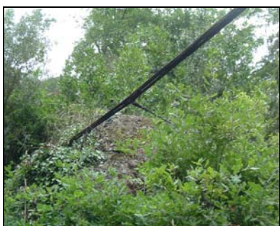
Figura 3.34 – Aspecto do encontro E1.
