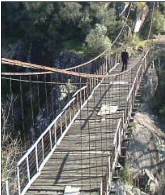
Figura 3.4 – Vista desde o encontro Noroeste.
