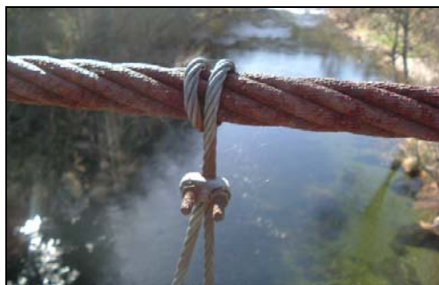
Figura 2.41 – Ligação entre cabos e pendurais.
