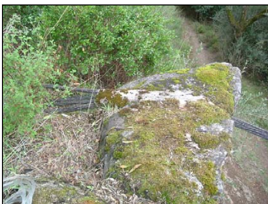
Figura 3.18 – Pormenor de ancoragem (encontro Sudeste a jusante).
