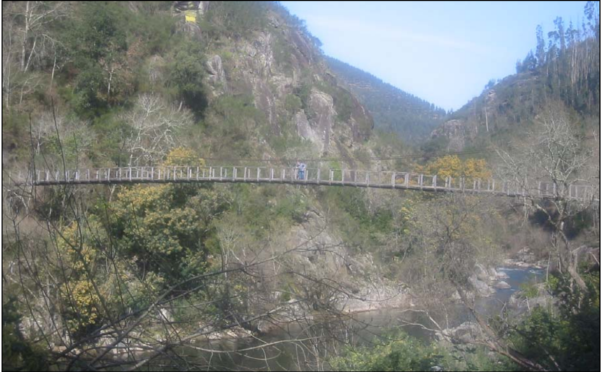
Figura 3.3 – Aspecto geral/enquadramento da ponte (vista de jusante).
