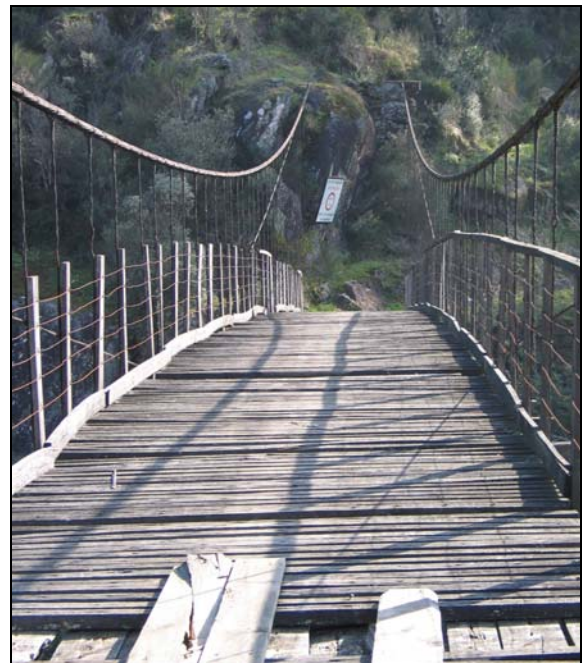
Figura 3.5 – Aspecto geral do pavimento.
