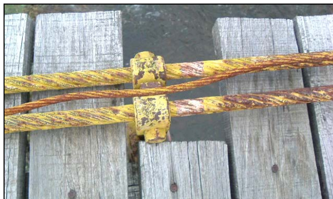
Figura 2.58 – Pormenor da ligação dos cabos principais.
