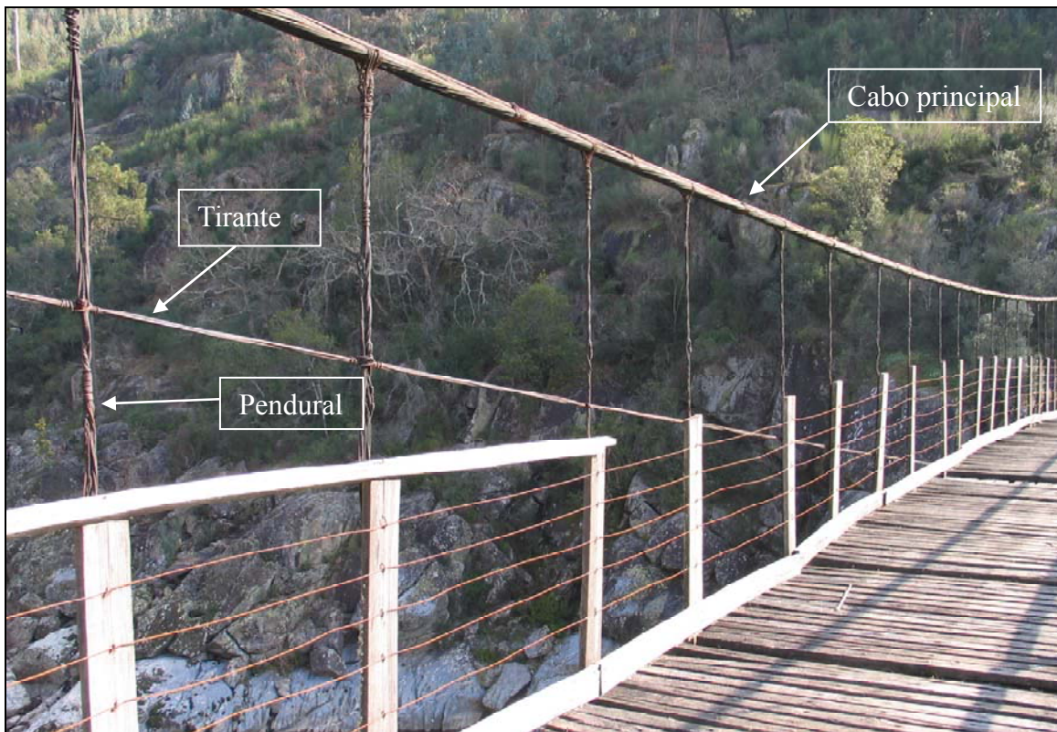
Figura 3.6 – Localização dos elementos estruturais metálicos.
