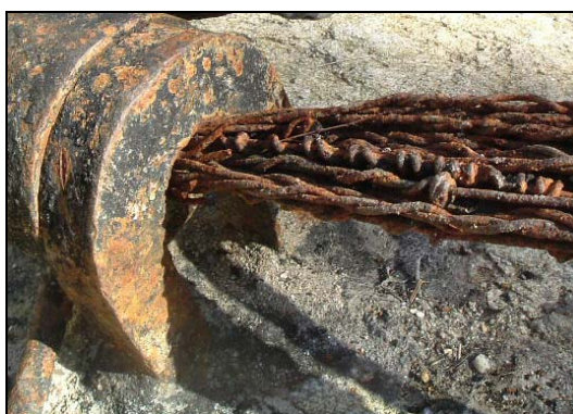
Figura 2.39 – Ancoragem dos cabos dos arames.
