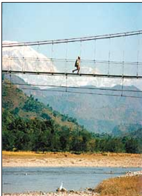
Figura 2.13 – Ponte Suspensa, Nepal (MC, 2005).
