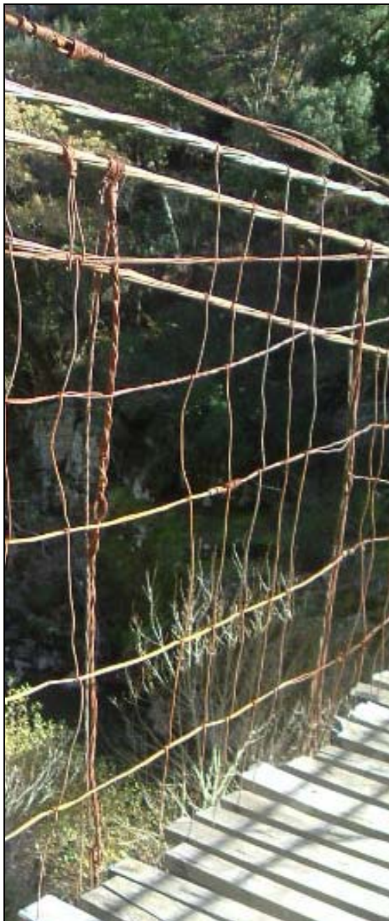
Figura 2.47 – Cabos principais, pendurais e guardas de segurança.
