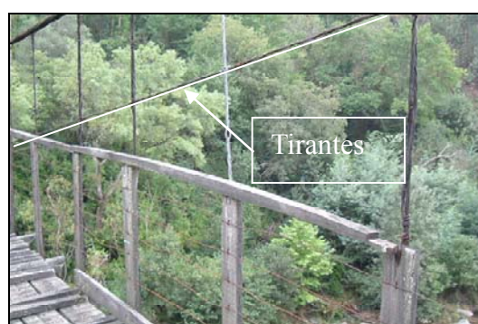
Figura 3.15 – Localização dos elementos designados por tirantes.
