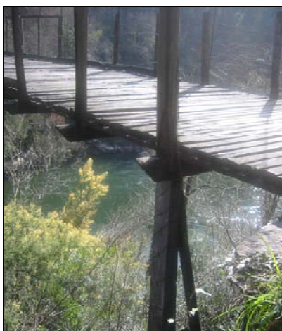
Figura 3.12 – Identificação dos barrotes e das guardas.
