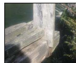
Figura 2.33 – Ligação entre as guardas e os barrotes.
