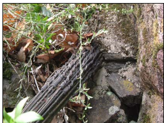
Figura 3.20 – Pormenor de ancoragem (encontro Noroeste a montante).
