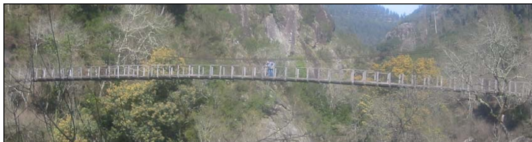
Figura 2.34 – Aspecto geral da ponte: vista de alçado.
