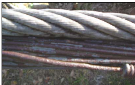
Figura 2.37 – Pormenor dos cabos principais.
