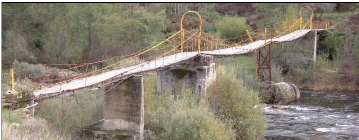
Figura 2.56 – Aspecto geral da Ponte de Cabos.
