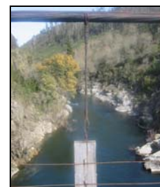
Figura 2.31 – Cabo principal, pendural e guardas de protecção.
