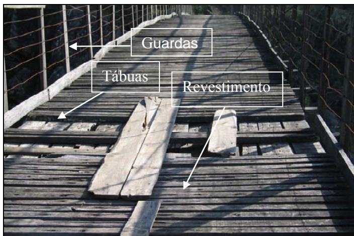
Figura 3.13 – Identificação do revestimento das tábuas e das guardas.
