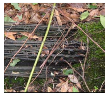
Figura 3.36 – Ancoragem de arames (encontro E1).
