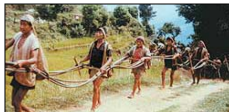
Figura 2.12 – Transporte de cabos para construção de pontes, Nepal (M C, 2005).
