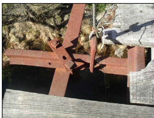
Figura 2.43 – Ligação entre perfis e pendurais.
