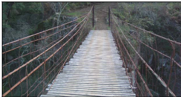
Figura 2.45 – Vista desde um dos encontros.
