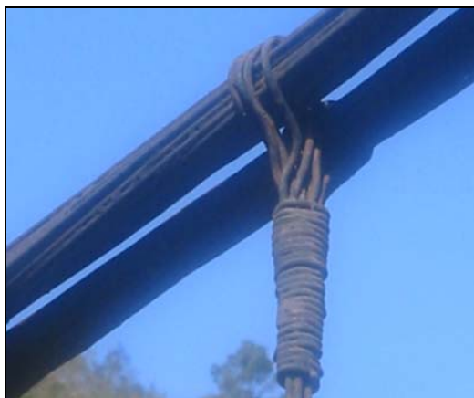
Figura 3.9 – Pormenor da ligação cabo/pendural.
