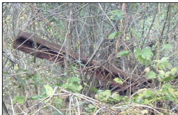
Figura 2.52 – Pilar derrubado.
