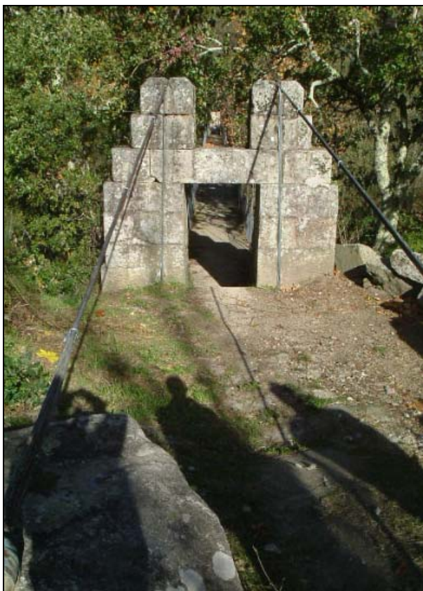
Figura 2.38 – Visto de um encontro.
