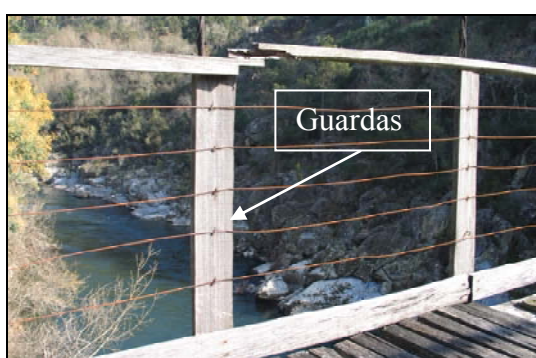
Figura 3.14 – Pormenor das guardas de protecção.
