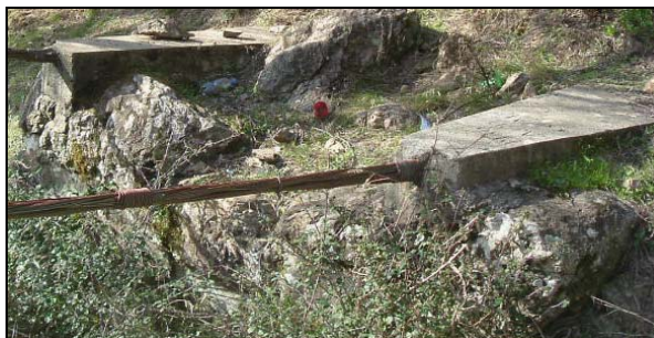
Figura 2.46 – Pormenor das ancoragens.
