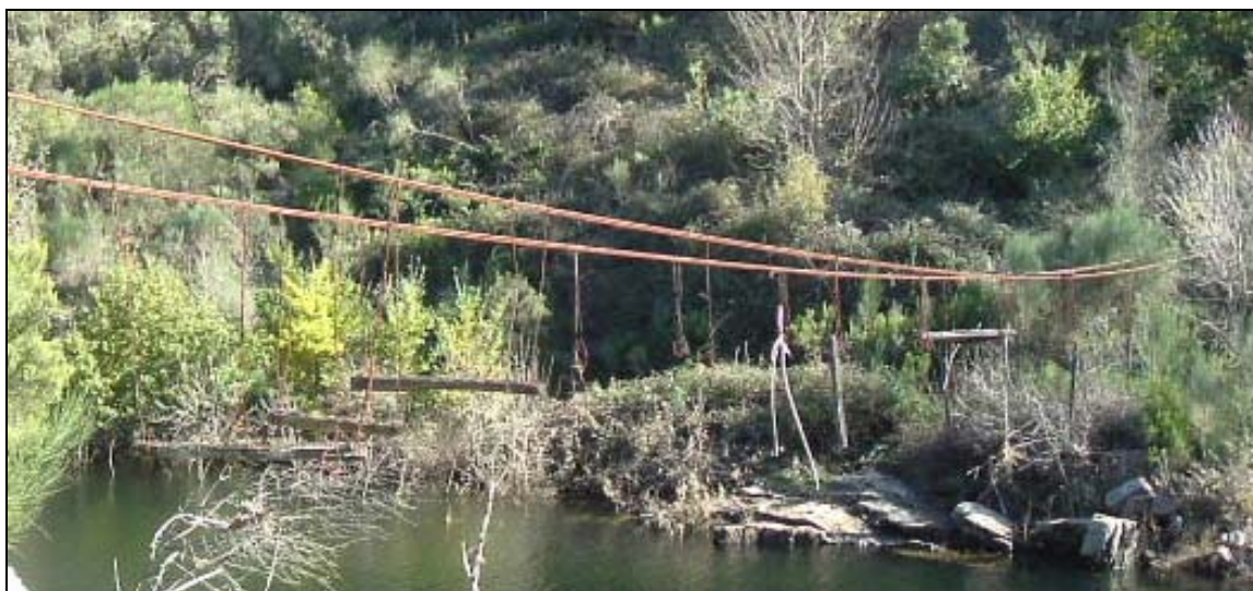
Figura 2.49 – Ponte de Padroselos.
