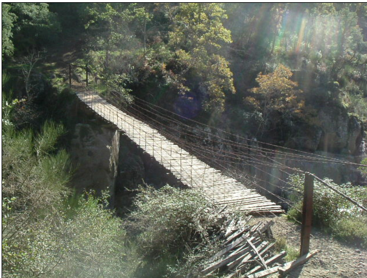
Figura 2.44 – Ponte de Veral.
