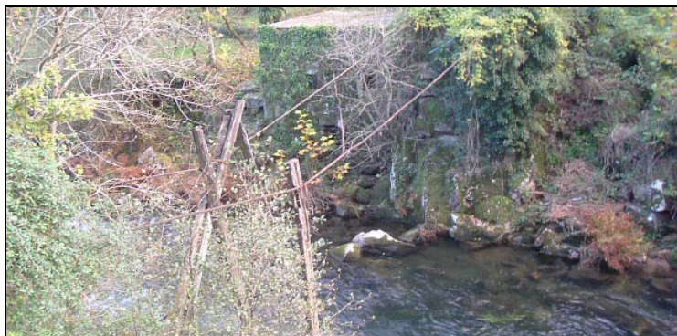
Figura 2.35 – Vista geral da Ponte de Pedraça.
