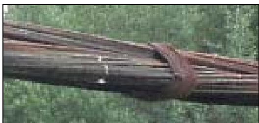
Figura 3.10 – Pormenor de um dos cabos principais.
