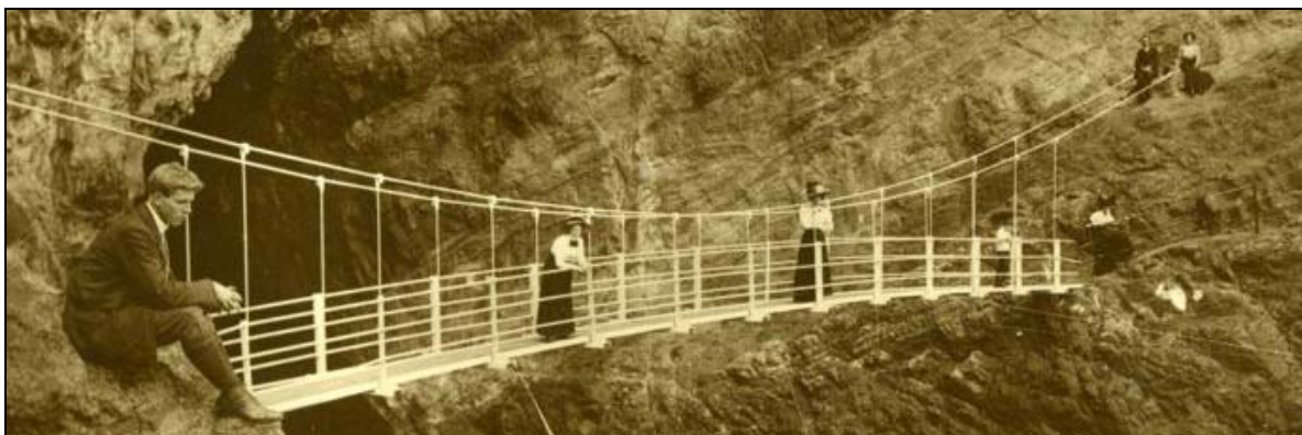
Figura 2.25 – Ponte de arame existente no Reino Unido (Bridgemeister, 2005).
