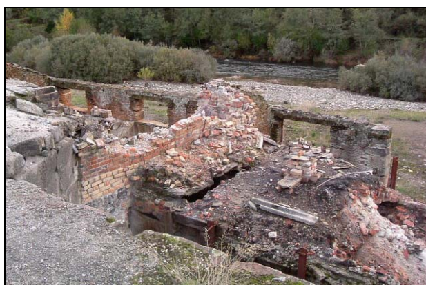
Figura 2.55 – Edifício de lavagem do minério.
