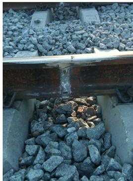
Figura 13 – Junta de carris soldada
