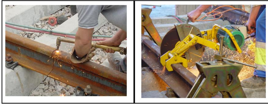
Fig.38 – Corte dos carris (soldadura aluminotérmica) [Adaptado de 41]
