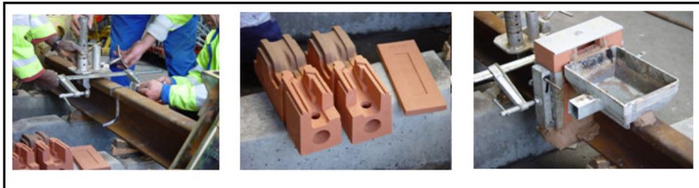
Fig.39 – Preparação e colocação do molde (soldadura aluminotérmica) [Adaptado de 41]
