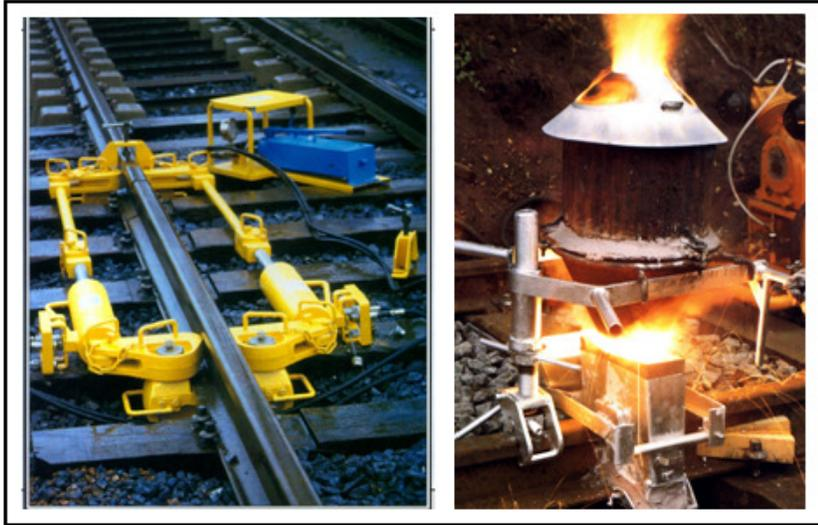
Fig.61 – Equipamentos de soldadura aluminotérmica (Adaptado de [41])
