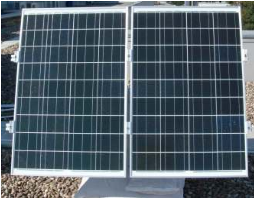
Figura 3.2.1 - Sistema de painéis fotovoltaicos KC85GX-2P da Kyocera®.
