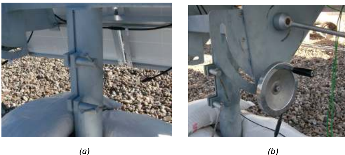
Figura 3.2.2 - Suporte dos painéis com sistema de rotação em: (a) azimute e (b) inclinação.
