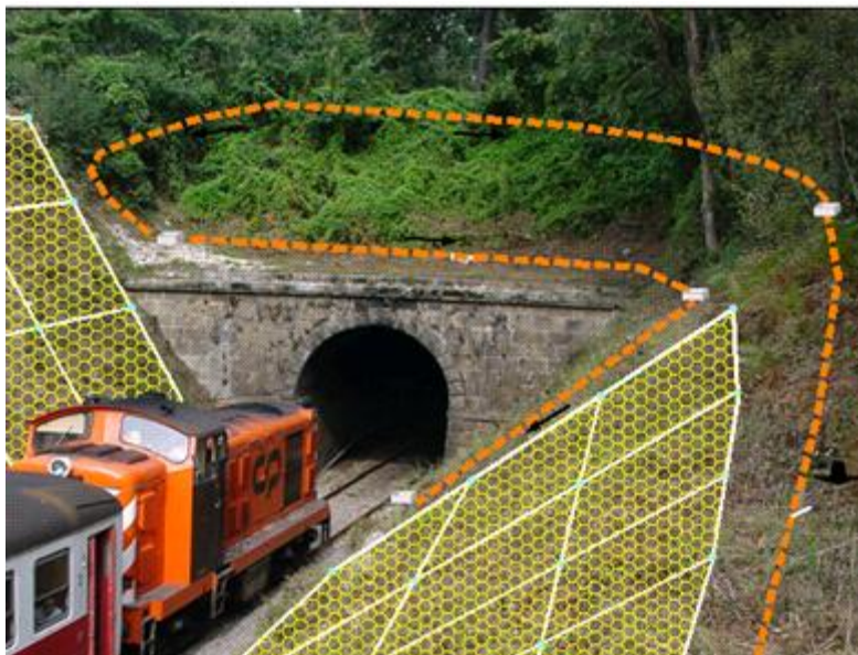
Fig.105 – Tratamento dos taludes (perspectiva 2), (GEG)
