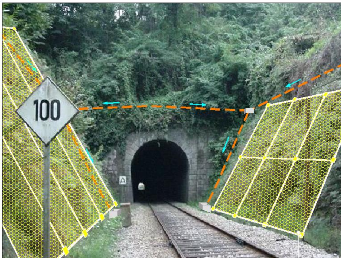
Fig.160 – Drenagem (GEG)
