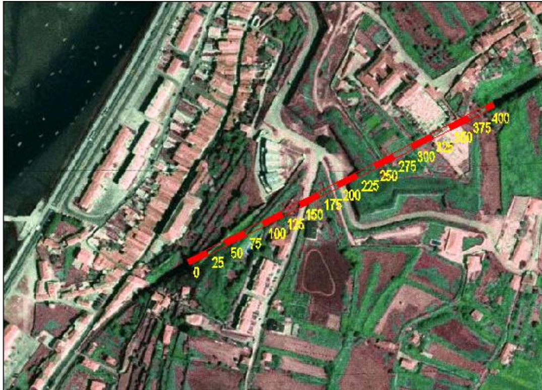
Fig.30 – Foto aérea da implantação do túnel de Caminha (GEG)
