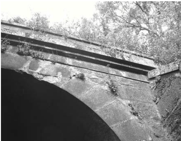
Fig.142 – Fissura e desprendimento na arquivolta (GEG)
