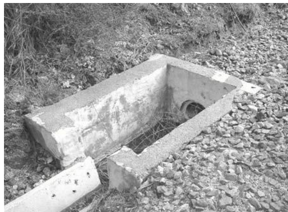
Fig.147 – Drenagem à entrada do túnel (lado esquerdo) (GEG)
