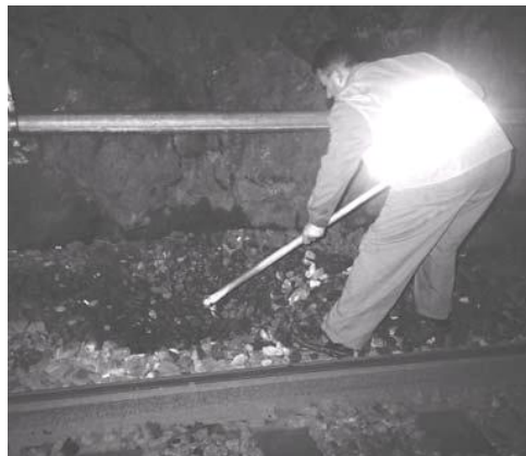
Fig.4 – Execução de poço na via (GEG)
