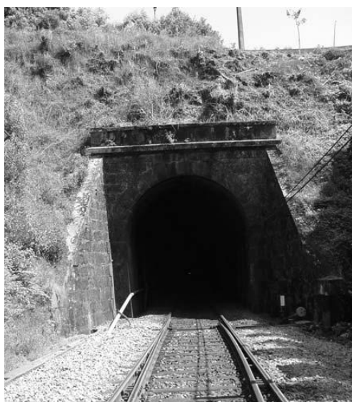
Fig.130 – Aspecto geral do emboquilhamento (GEG)
