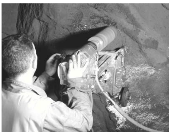
Fig.12 – Extracção de carote (GEG)
