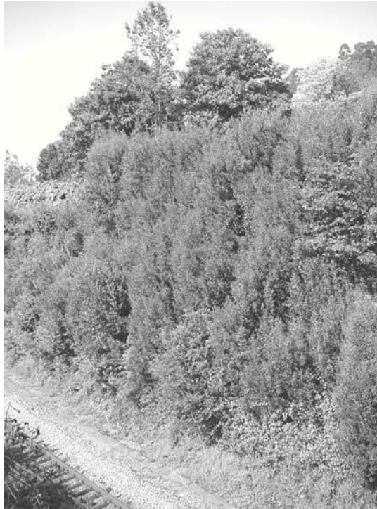
Fig.128 – Talude do lado direito (GEG)
