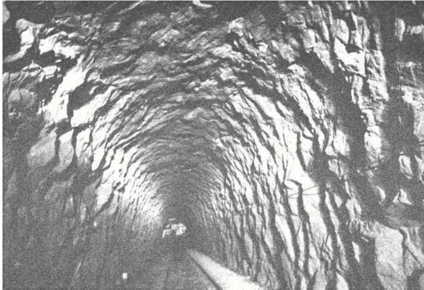
Fig.38 – Aspecto do túnel nas zonas não revestidas (GEG)
