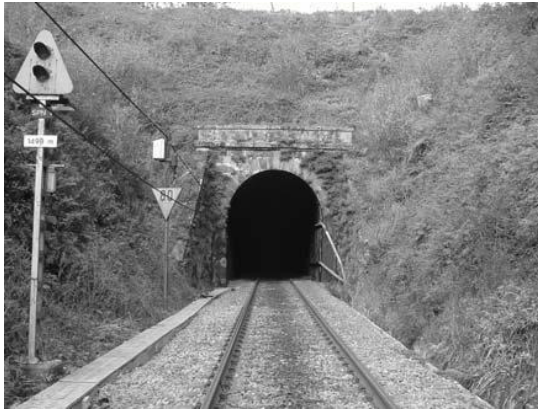
Fig.117 – Boca de entrada (GEG)
