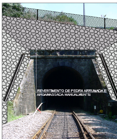
Fig.132 – Revestimento de pedra arrumada e argamassada manualmente (GEG)
