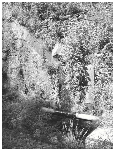
Fig.123 – Muro ala do lado direito (GEG)
