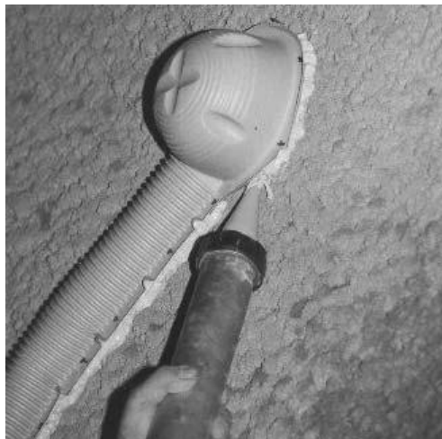
Fig.64 – Selagem do tampão de recolha (GEG)
