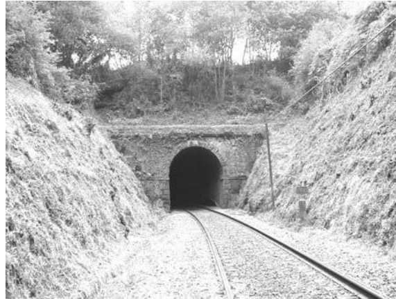
Fig.98 – Boca de saída após desmatamento (GEG)
