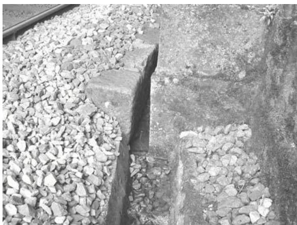
Fig.152 – Aspecto da caleira existente à saída do túnel (GEG)
