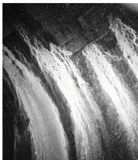
Fig.39 – Rompimento do sistema de drenagem (GEG)
