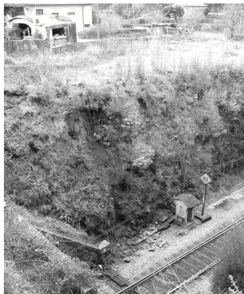
Fig.126 – Escorregamento recente do lado esquerdo (GEG)
