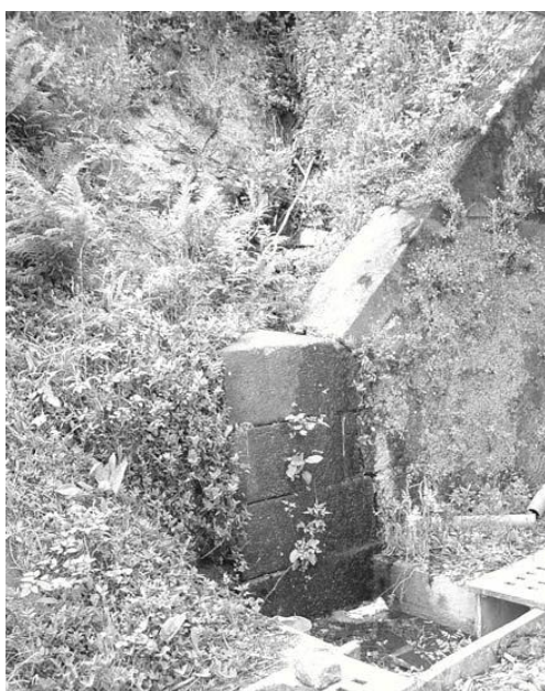
Fig.122 – Muro ala do lado esquerdo (GEG)
