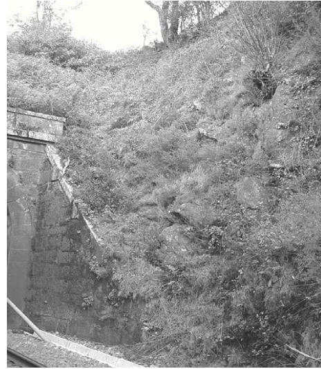
Fig.140 – Muro ala existente do lado direito (GEG)
