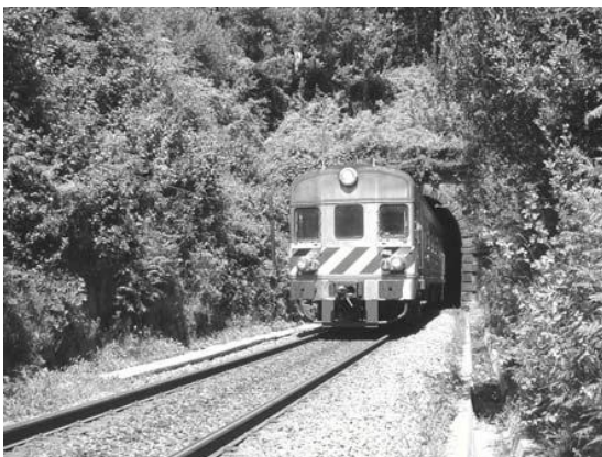
Fig.95 – Boca de entrada (GEG)
