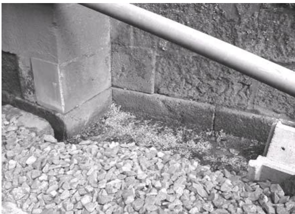
Fig.147 – Drenagem à entrada do túnel (lado esquerdo) (GEG)
