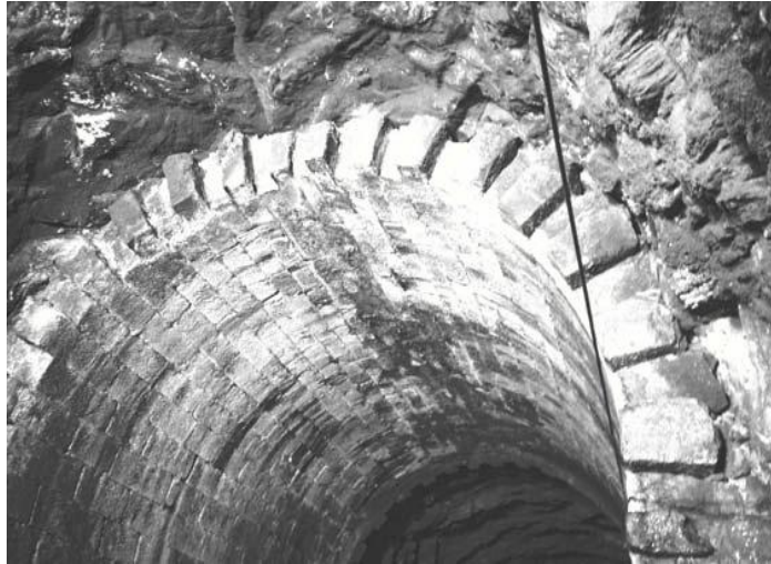
Fig.43 – Trecho revestido a alvenaria (GEG)
