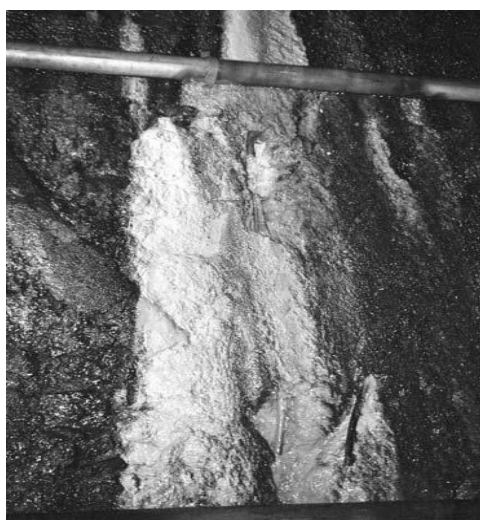
Fig.39 – Rompimento do sistema de drenagem (GEG)
