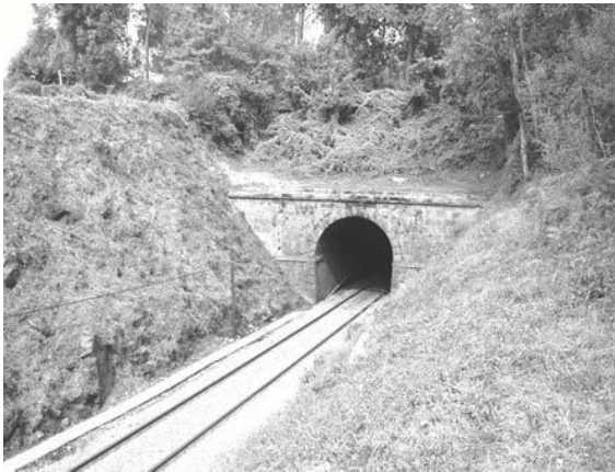
Fig.97 – Boca de entrada após desmatamento (GEG)
