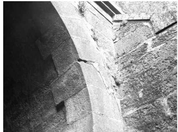
Fig.142 – Fissura e desprendimento na arquivolta (GEG)
