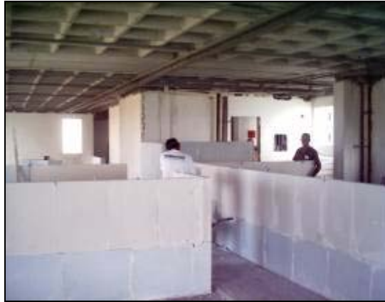
Figura 20 – Paredes divisórias em blocos de gesso Fonte: Construtora Castelo Branco e os Cinco Princípios Lean. (2007).
