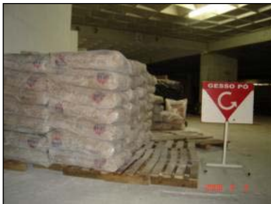
Figura 21 – Kanban de Sinalização Fonte: Construtora Castelo Branco e os Cinco Princípios Lean. (2007).
