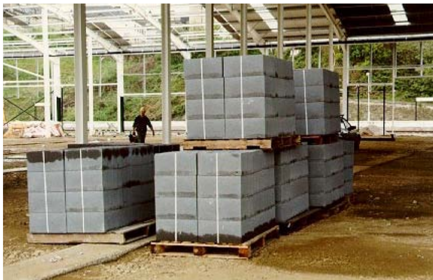
Figura 13 – Paletização de blocos de alvenaria Fonte: Formoso, C.
