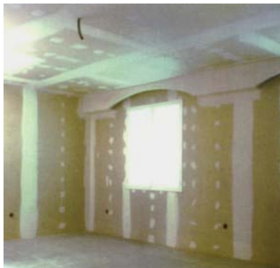
Figura 11 – Divisórias em gesso cartonado
