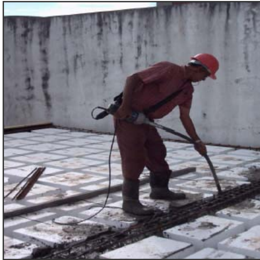
Figura 10 – Operário a usar vibrador portátil Fonte: Kurek, J. (2005)
