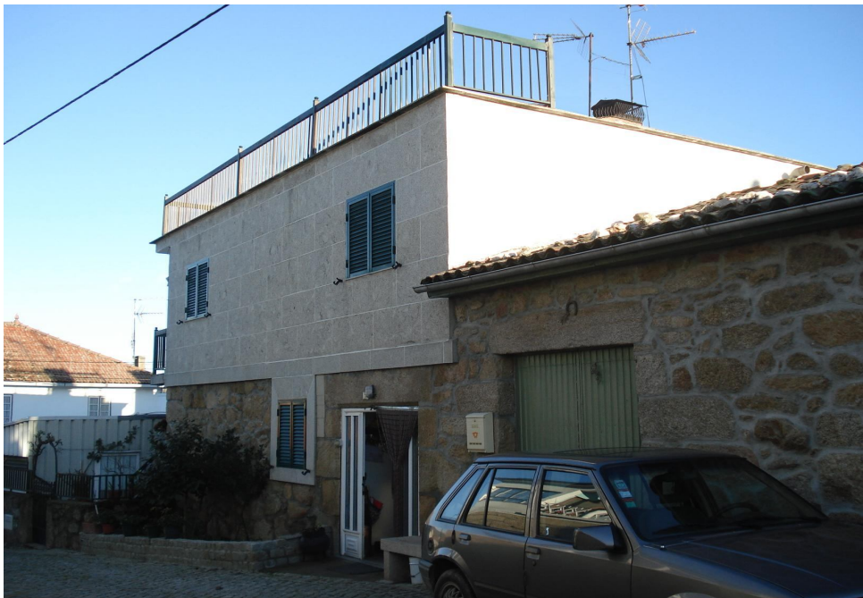
Fig. 4.13: Fachada principal da habitação referente ao caso 3
