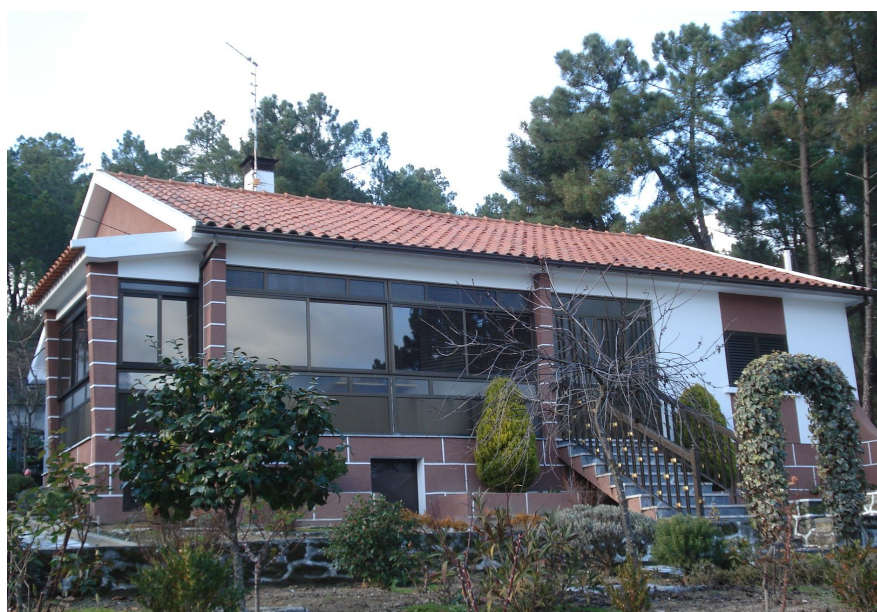
Fig. 4.2: Fachada principal da habitação referente ao caso 1
