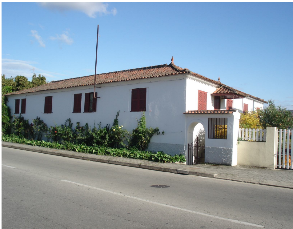
Fig. 4.8: Fachadas orientadas a sul (esquerda) e este (direita) da habitação, referentes ao caso 2
