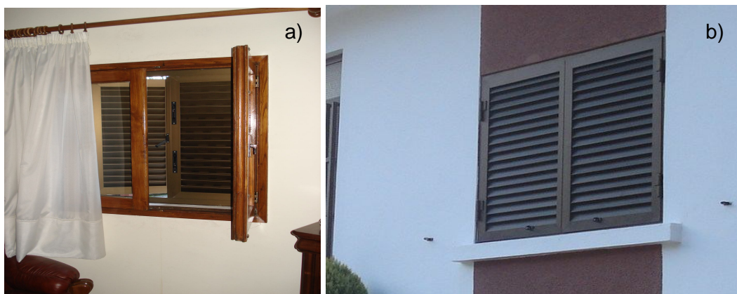
Fig. 4.6 a) e 4.6 b): a) Envidraçado simples com cortina transparente e caixilharia de madeira; b) Vista da protecção exterior de alumínio
