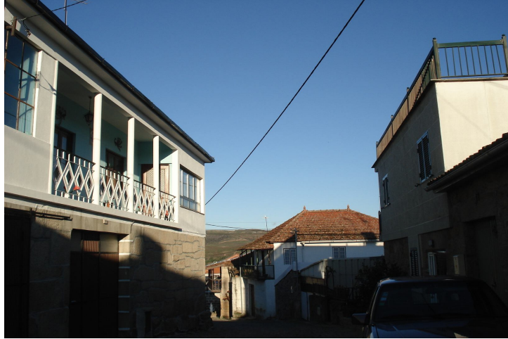
Fig. 4.15: Obstrução provocada à habitação por um edifício
