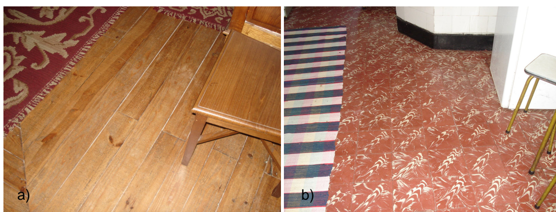
Fig. 4.10 a) e 4.10 b): a) Vista superior do pavimento interior; b) Vista superior do pavimento interior revestido.
