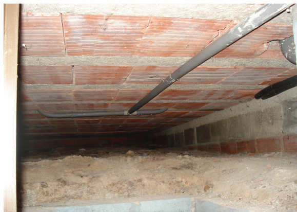
Fig. 4.4 : Zona não útil abaixo do pavimento da casa (Caixa-de-ar)
