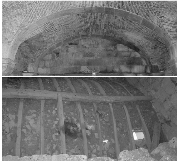
Fig. 3 – Pavimento com estrutura em abóbada (Sousa [19])
