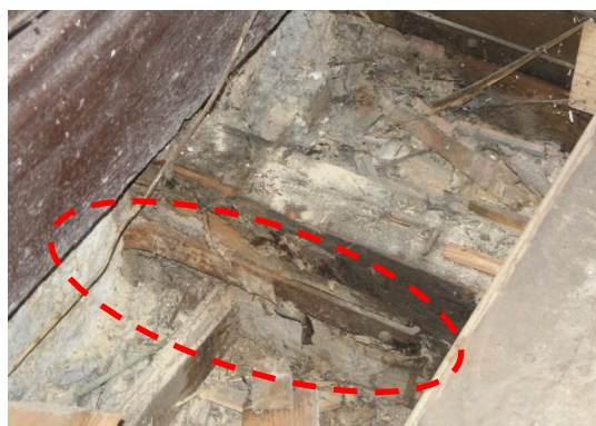
Fig. 11 – Pormenor da ligação do ferrolho à viga de pavimento. (Edifício da R. José Falcão nº95 – Porto)
