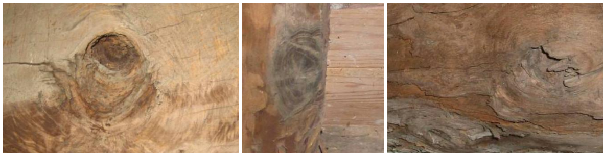
Fig. 33 – Nós em vigas de pavimentos. (Dias [18])
