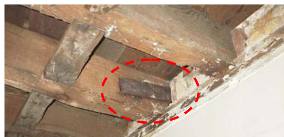
Fig. 17 – Apoio de vigas em frechal. Pormenor de um ferrolho de ligação. (Cóias [6])
