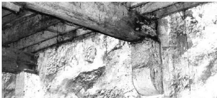
Fig. 15 – Viga apoiada em cachorro de pedra (Sousa [19])
