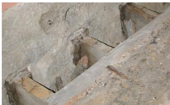
Fig. 9 – Entrega das vigas. (Edifício da R. José Falcão nº95 – Porto)
