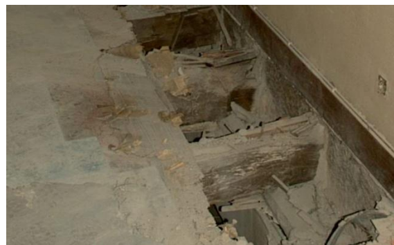
Fig. 10 – Entrega das vigas. (Edifício da R. do Infante D. Henrique nº87-91 - Porto)
