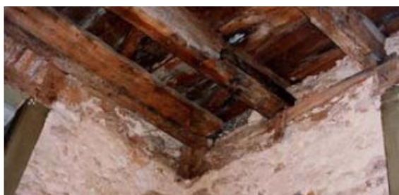
Fig. 16– Apoio de vigas em frechal (Cóias [6])
