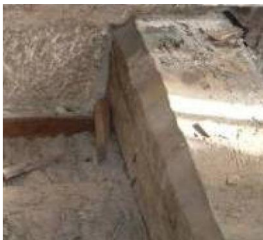
Fig. 7 – Vigas com arestas chanfradas (Dias [18])
