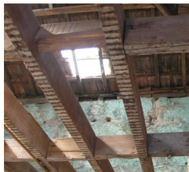
Fig. 8 – Vigas de secção rectangular (Edifício da R. José Falcão nº95 – Porto)
