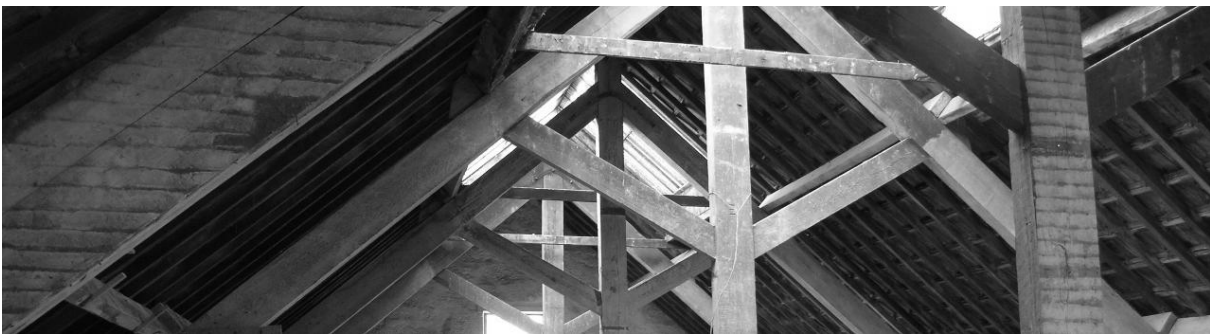
Fig. 4 – Cobertura tradicional de duas águas. (Edifício da R. José Falcão nº95 – Porto)
