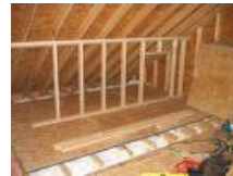
Fig. 3.21 – Exemplo de aplicação de placas de “OSB”
