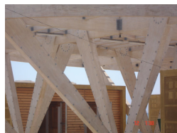
Fig. 3.16 – Estrutura em lamelado colado
