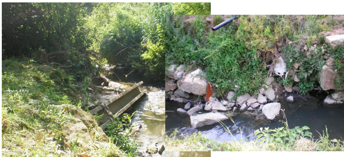
Figura 4.22 – Evidência da presença de resíduos nas margens e leito do rio na zona do Parque Oriental
