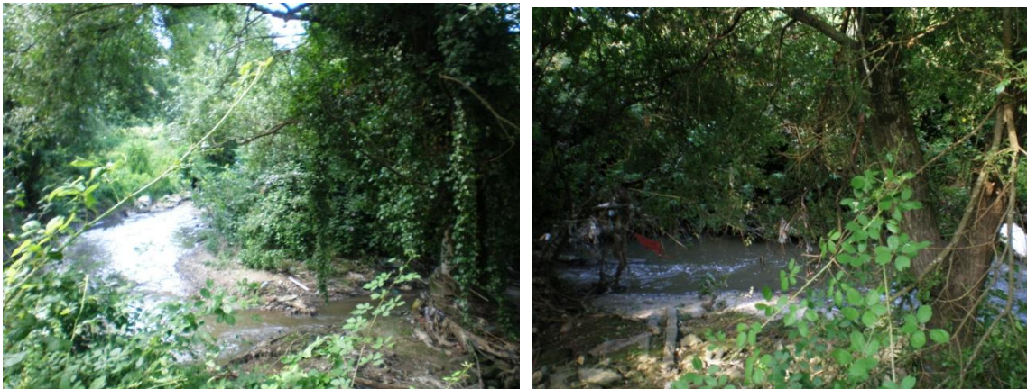
Figura 4.15 - Vista geral do sub-troço considerado
