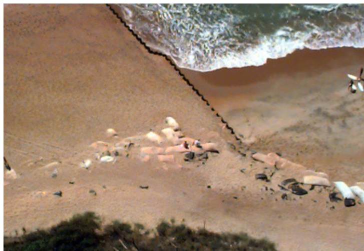
Fig.2.6 – Esporão metálico ( http://stevekluge.com/geoscience/images/groin.jpg ).
