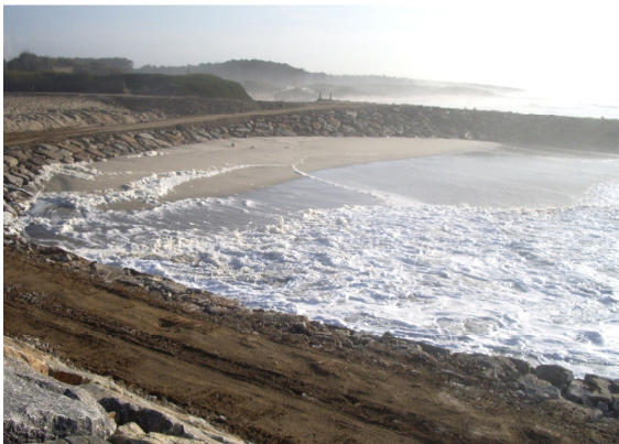
Fig.D.8 – Troço sul da estrutura longitudinal aderente da frente edificada, antes do reperfilamento da banquetta, na praia velha em Cortegaça (13.01.2009)
