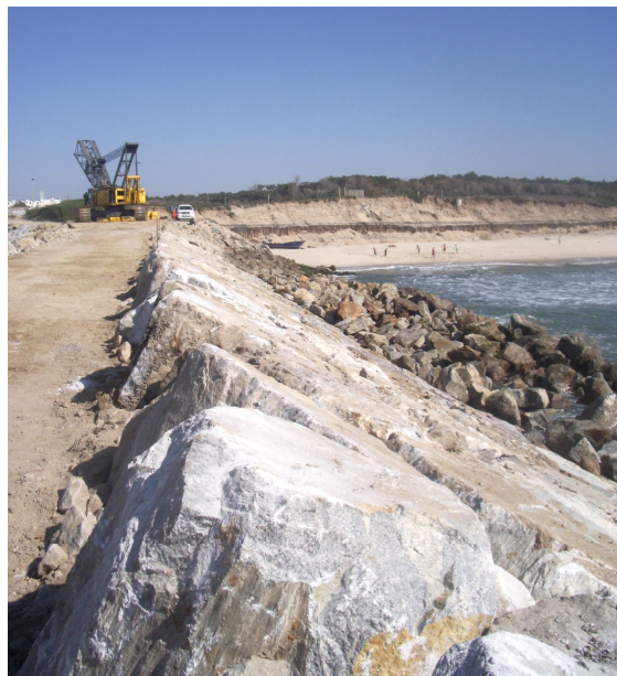
Fig.D.15 – Talude sul do esporão de Cortegaça pronto, faltando o enraizamento (a rectificar o alinhamento, a reposicionar uma caixa e descarga de águas pluviais) (18.03.2009).
