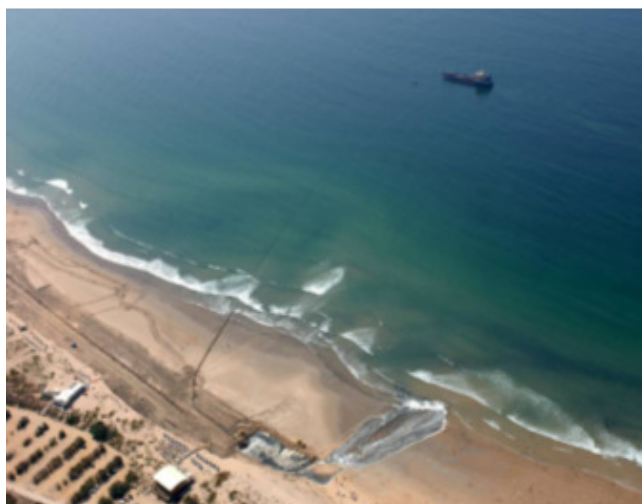
Fig.C.54. – Alimentação das praias da Costa da Caparica com draga fundeada a repulsar para a praia através de um pipe-line submerso (Velooso Gomes, 2009).
