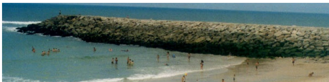
Fig.C.13. – Esporão da praia do Furadouro, Ovar (GeoSNIRH).
