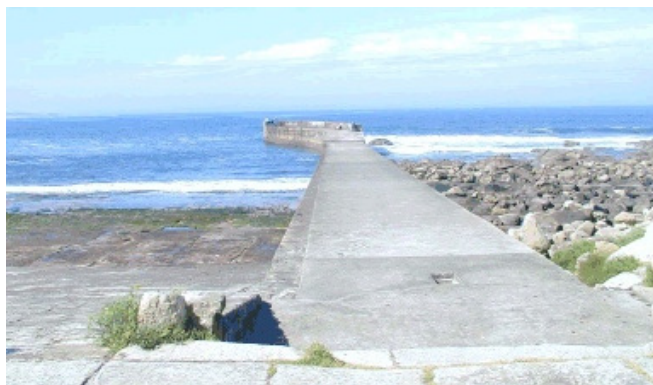
Fig.C.6. – Quebramar norte de Vila Praia de Âncora (GeoSNIRH).
