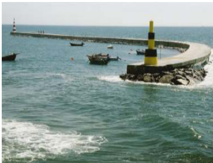
Fig.2.27 – Quebramar destacado da praia Aguda, antes da formação do tómbolo (Instituto da Água, 2002).
