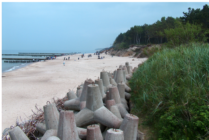
Fig.2.21 – Estrutura longitudinal aderente na Polónia composta por tetrápodes (fotografia de F. Kasimierz, Julho de 2005).
