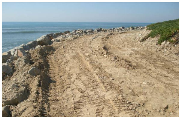
Fig.D.13 – Talude superior da frente edificada, em Cortegaça (18.03.2009).
