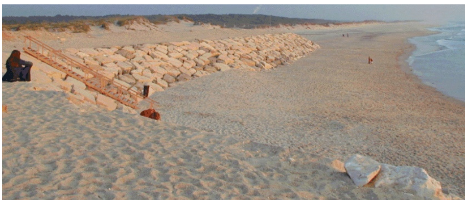
Fig.C.38. – Defesa frontal em Cova (GeoSNIRH).
