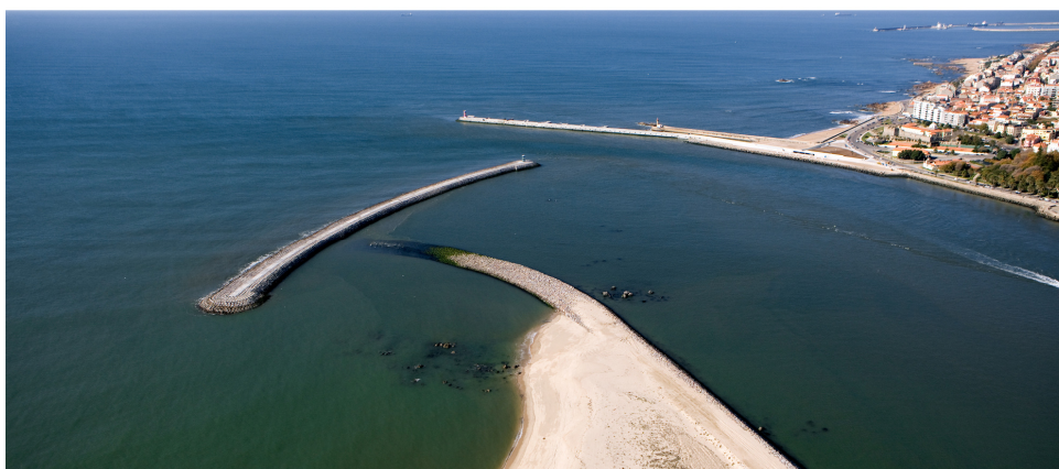
Fig.2.28 – Quebramar destacado e molhes do Douro ( http://www.grandeportotv.net/catalog/productImages/obras_molhe.jpg ).
