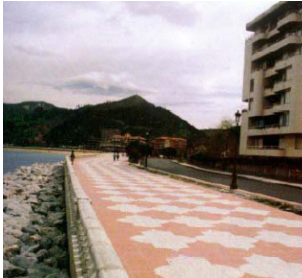
Fig.2.14 – Estrutura de defesa longitudinal aderente na praia de Castro Urdiales em Cantábria, Espanha (Taboada, 1988).
