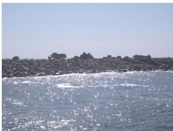
Fig.D.16 – Esporão de Cortegaça com taludes reperfilados faltando apenas a cabeça (18.03.2009).
