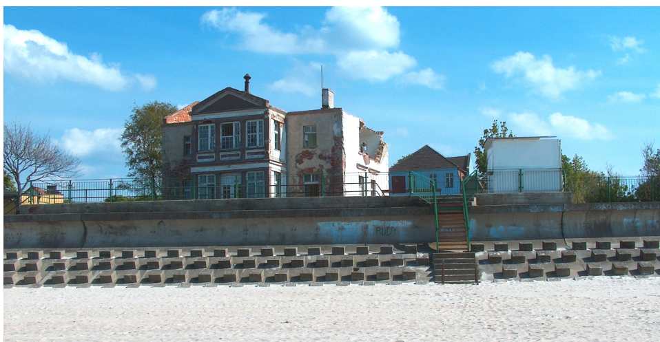
Fig.2.19 – Estrutura de defesa longitudinal aderente na Polónia (fotografia de F. Kasimierz, Julho de 2005).
