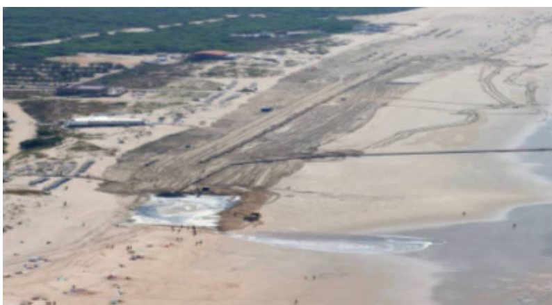
Fig.C.55. – Alimentação das praias da Costa da Caparica. Extremidade do pipe-line de repulsão e trabalhos de reperfilamento na praia (Velooso Gomes, 2009).
