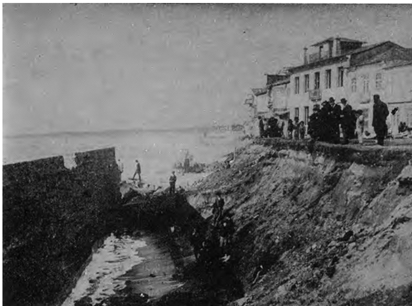
Fig.2.13 – Aspecto da estrutura longitudinal aderente construído em Espinho em 1909, após a actuação dos temporais de 1910 (reprodução de fotografia da época extraída de Teixeira, 1980).
