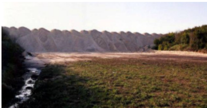
Fig.C.53. – Construção de diques artificiais pelo INAG, em grandes extensões a sul da barra de Aveiro (Velooso Gomes, 2009).
