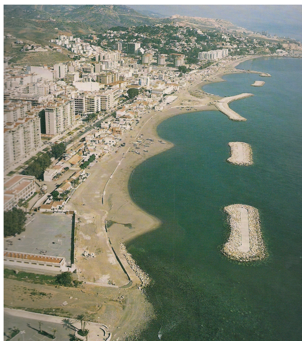
Fig.C.47. – Campo de quebramares destacados na praia de El Palo, Malaga (Taboada, 1988).
