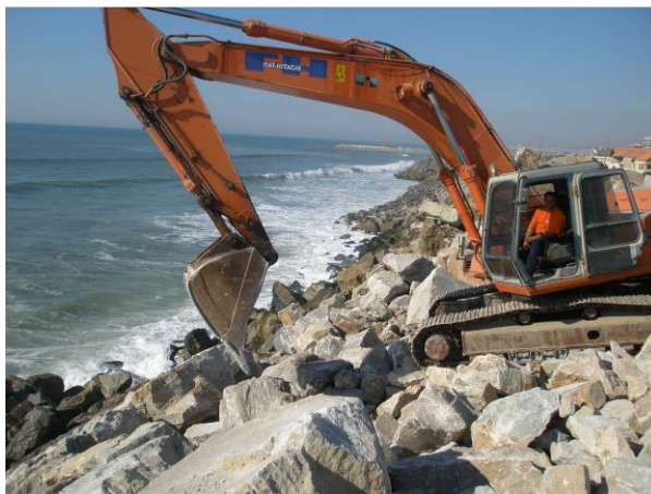
Fig.D.2. – Obra longitudinal aderente a norte da rampa de acesso das embarcações, em Esmoriz (18.03.2009).
