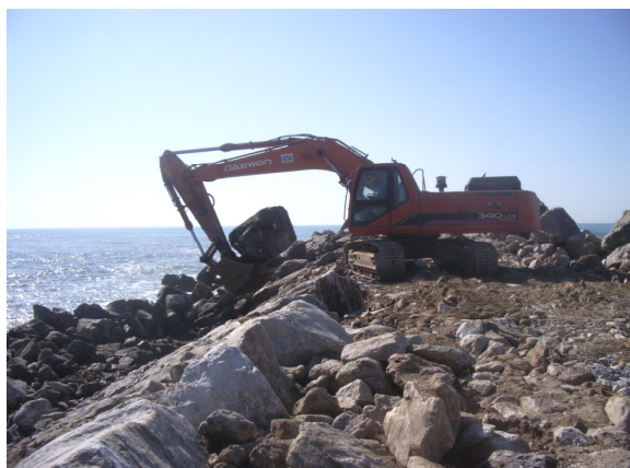
Fig.A.6 – Giratória executando trabalhos de colocação de enrocamento no talude do tronco de esporão, em Cortegaça (18.03.2009).
