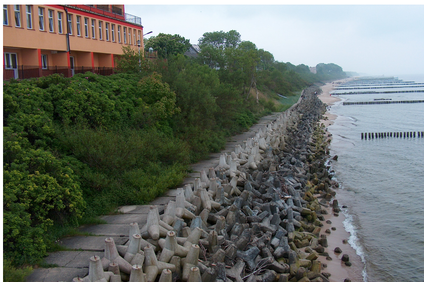
Fig.2.22 – Estrutura longitudinal aderente e campo de esporões permeáveis, em madeira, na Polónia (fotografia de F. Kasimierz, Julho de 2005).
