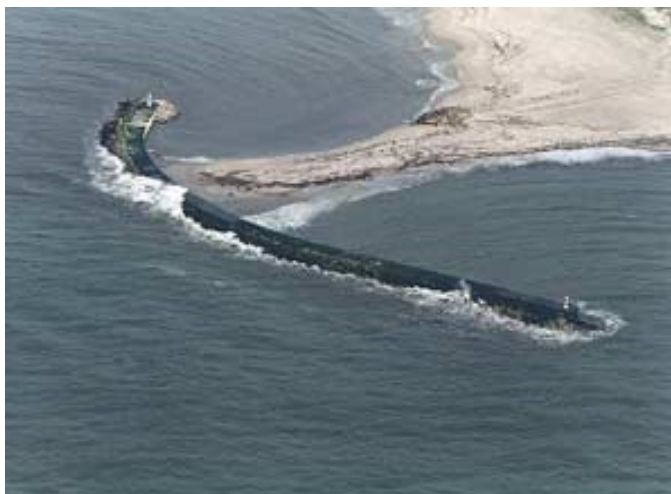
Fig.2.26 – Quebramar destacado de Castelo de Neiva ( http://www.seth.pt/obras.asp?idCat=2 , Junho de 2009).
