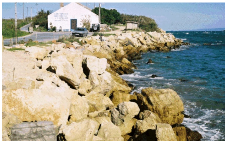
Fig.C.41. – Defesa frontal em Peniche de Cima (GeoSNIRH).
