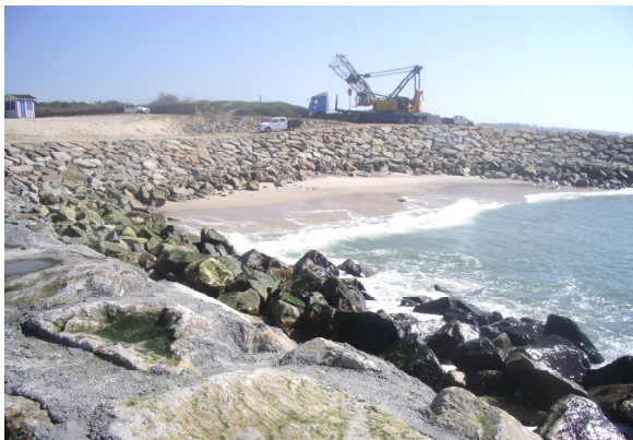
Fig.D.10 – Troço sul da estrutura longitudinal aderente da frente edificada, após reperfilamento da banquetta intermédia, em Cortegaça (18.03.2009).
