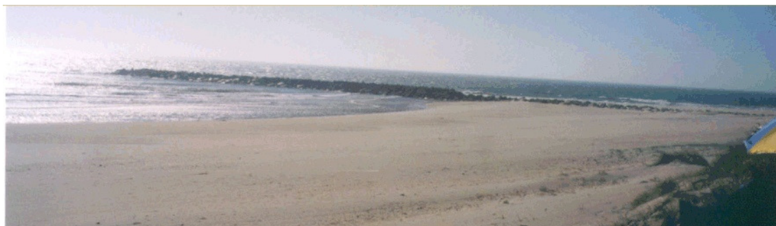
Fig.C.46. – Quebramar destacado de Castelo de Neiva, foz do rio Neiva (GeoSNIRH).
