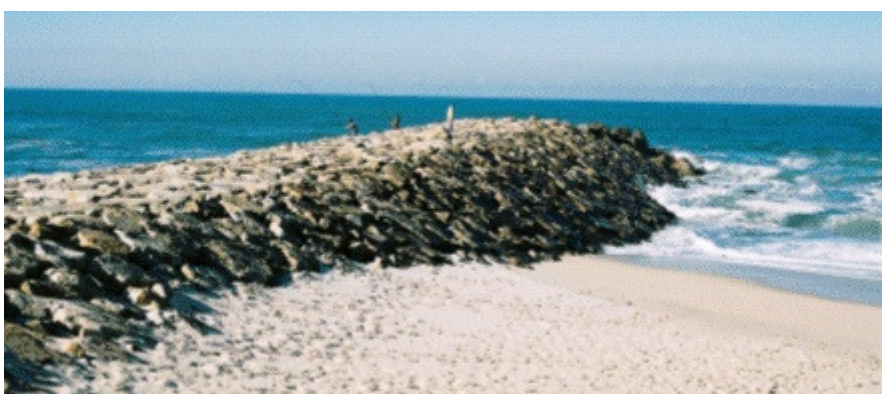
Fig.C.14. – Esporão da praia da Costa Nova (GeoSNIRH).
