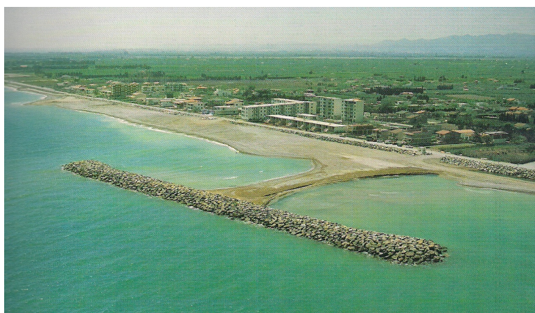
Fig.C.51. – Quebramar destacado na praia de Almazora, Castellon (Taboada, 1988).
