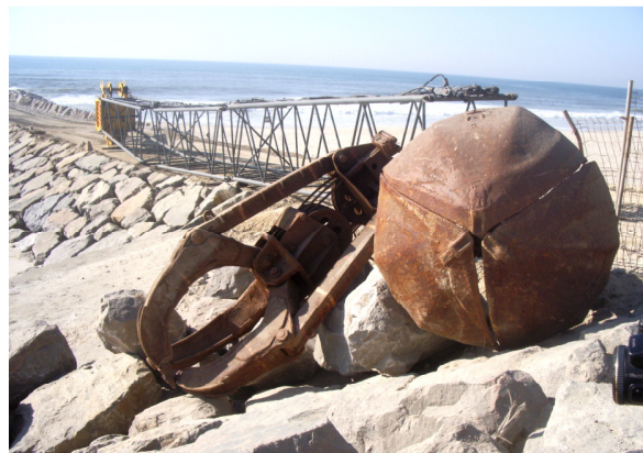
Fig.A.4 – Dispositivos de auxílio da grua na colocação de blocos na obra, em Esmoriz (18.03.2009).
