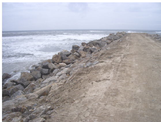
Fig.D.22 – Esporão da praia da Vagueira sofrendo trabalhos de reperfilamento de taludes (9.05.2009).
