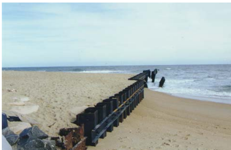
Fig.C.2. – Esporão constituído com estacas prancha metálicas no cabo de Hatteras (fotografia de Blair Tormey, 1998).
