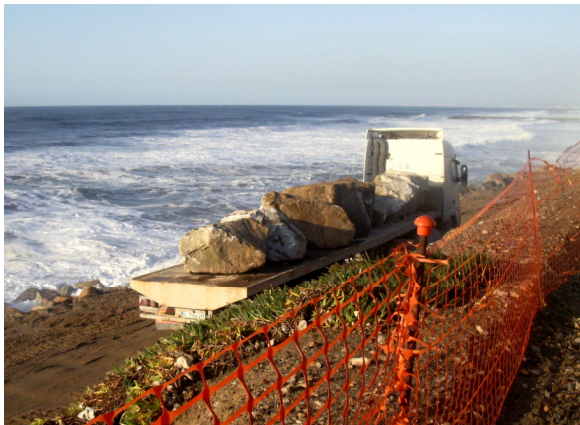
Fig.A.1 – Camião transportando enrocamento para colocação em obra, em Cortegaça (13.01.2009).
