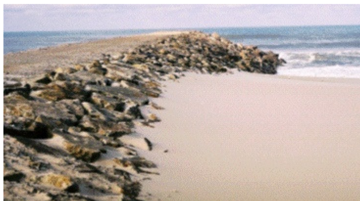
Fig.C.16. – Esporão da praia da Vagueira (GeoSNIRH).
