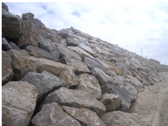
Fig.D.19 – Estrutura longitudinal aderente da frente edificada, com talude exposto reperfilado na zona mais a sul, na Vagueira (9.05.2009).
