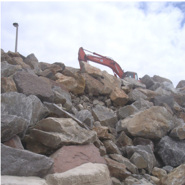
Fig.D.17 – Estrutura longitudinal aderente da frente edificada, antes do reperfilamento do talude exposto, na Vagueira (9.05.2009)
