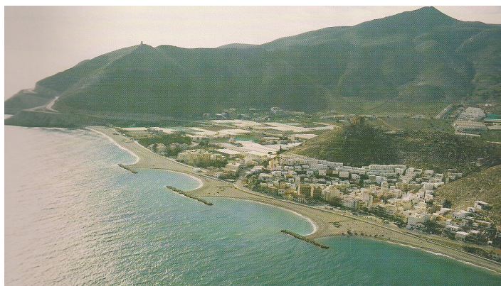
Fig.C.49. – Campo de quebramares destacados na praia de Castell de Ferro, Granada (Taboada, 1988).
