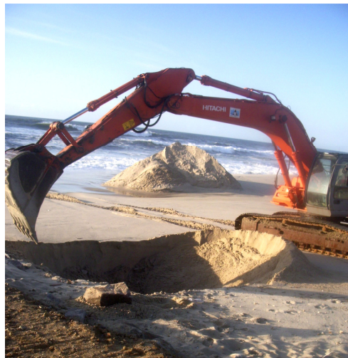
Fig.A.2 – Giratória realizando trabalhos de remoção de areia junto ao enraizamento do esporão norte de Esmoriz (13.01.2009).
