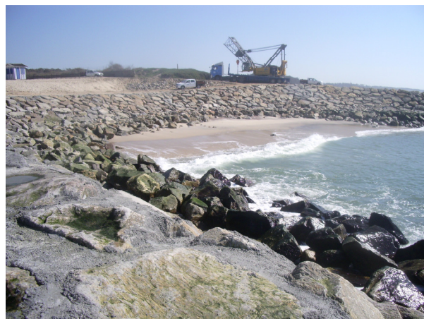
Fig.A.7 – Grua de grande porte em fase de montagem , junto do enraizamento do esporão Norte de Cortegaça (18.03.2009).
