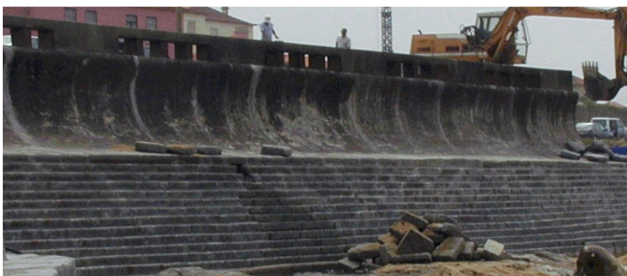
Fig.C.32. – Paredão na praia da Granja (GeoSNIRH).
