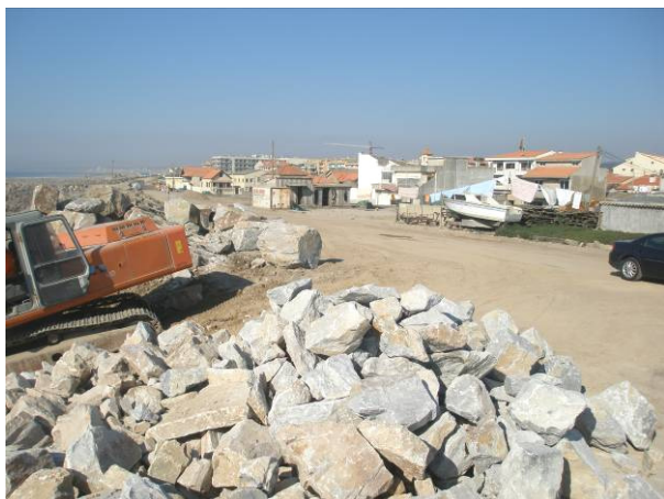
Fig.D.7. – Construções e anexos recentes a norte da rampa de acesso das embarcações em Esmoriz (18.03.2009).
