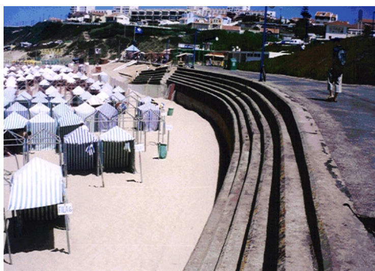
Fig.C.42. – Paredão na praia de Santa Cruz (GeoSNIRH).
