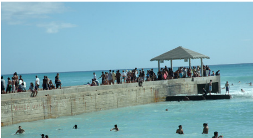
Fig.2.5 – Esporão de Kapahulu em betão armado pré-fabricado na praia de Waikiki em Hawaii (fotografia de Kathleen Walling Fry).
