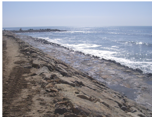
Fig.D.11 – Troço sul da estrutura longitudinal aderente, após reperfilamento da banquetta intermédia e betonagem entre blocos, em Cortegaça (18.03.2009).
