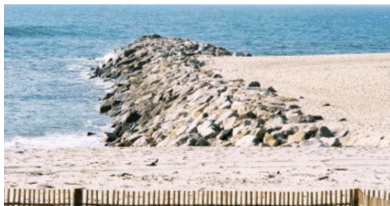
Fig.C.11. – Esporão da praia da Madalena (GeoSNIRH).
