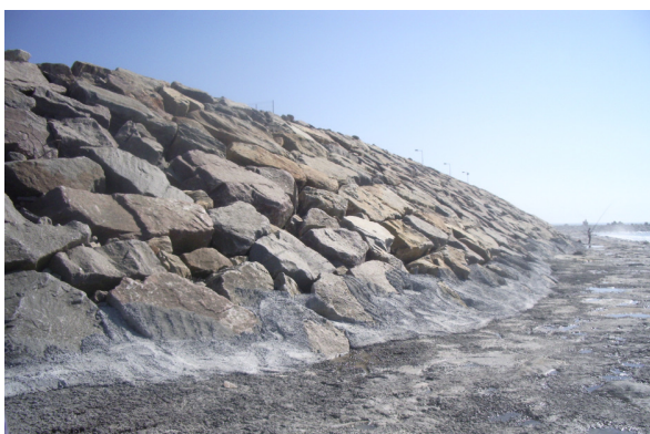
Fig.D.12 – Estrutura longitudinal aderente da frente edificada, com talude intermédio todo reperfilado mostrando os remates face ao talude superior, em Cortegaça (18.03.2009).
