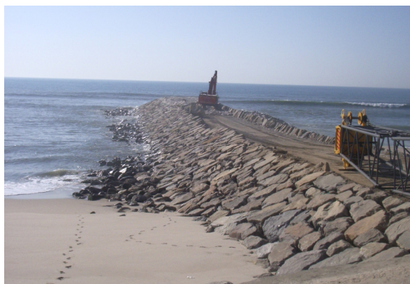
Fig.D.4. – Esporão norte de Esmoriz, com talude sul reperfilado e coroamento em execução (18.03.2009).
