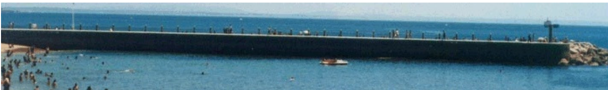
Fig.C.20. – Esporão na praia do Tamariz (GeoSNIRH).
