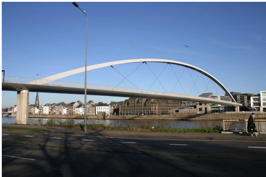
Fig. 2.7 – Hoge Brug footbridge – Maastricht [10]
