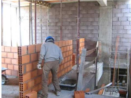
Fig.39- Assentamento de alvenaria
