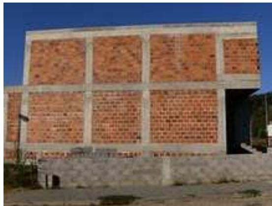
Fig.36- Estrutura porticada de betão armado
