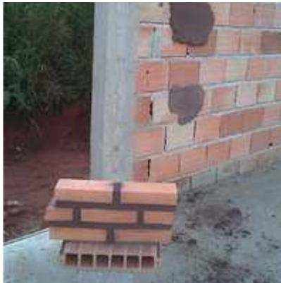
Fig.9- Argamassa para assentamento de alvenarias
