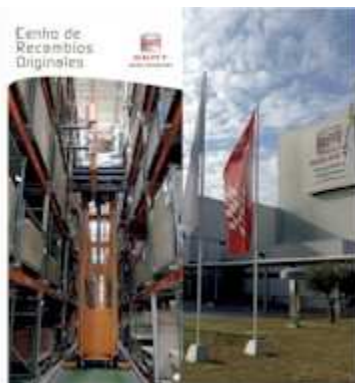
Figura 7 – Centro de Recâmbios Originais.
