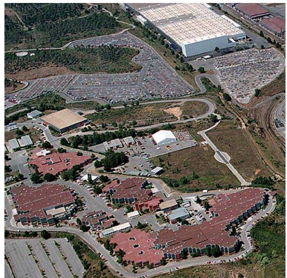
Figura 4 – Centro Técnico de Martorell
