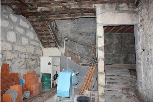
Fig. 4.8 – Mostra geral das paredes em alvenaria de pedra (granito) do rés-do-chão.
