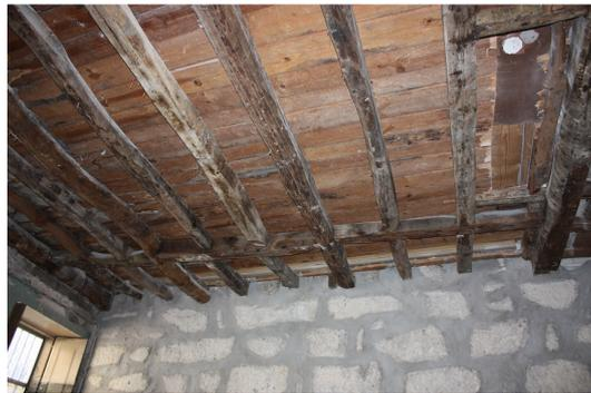
Fig. 4.15 – Pormenor do pavimento do piso 1 (tecto do rés-do-chão).
