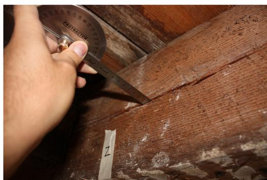
Fig. 4.38 – Medição de fendas.
