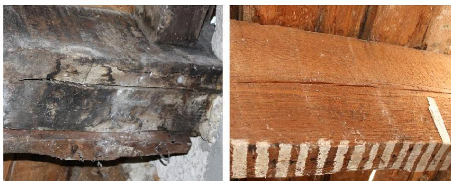
Fig. 3.2 – Presença de fendas em vigas de pavimentos.
