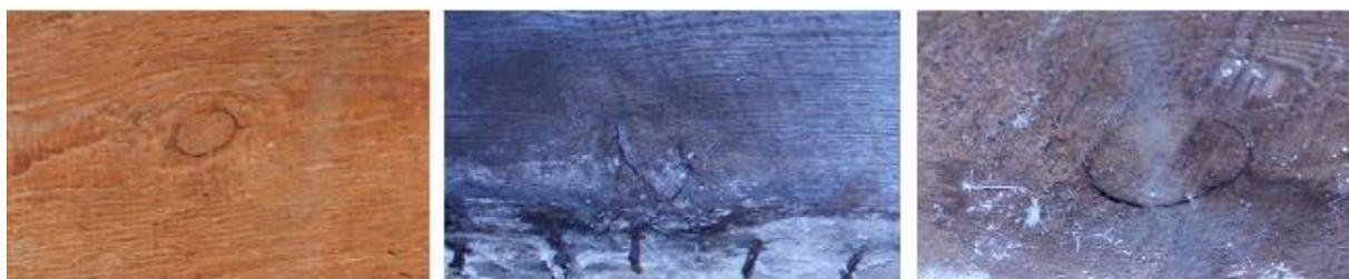
Fig. 3.1 – Presença de nós de diversas formas em vigas de pavimentos.
