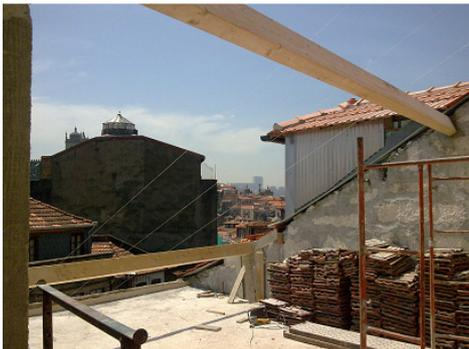
Fig. 4.31 – Nova cobertura do corpo principal (futura janela da antiga trapeira).
