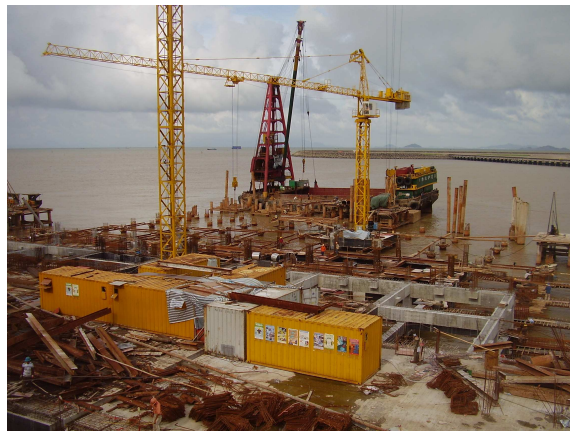
Figura 1. 3 – Estaleiro na Ilha da Taipa
