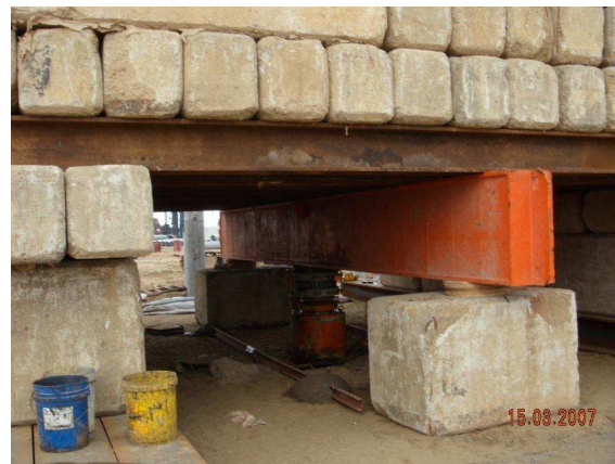
Figura 1. 7 – Disposição do macaco hidráulico e sistema de reacção
