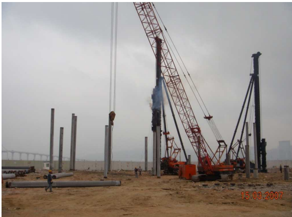
Figura 1. 4 – Cravação de estacas PHC
