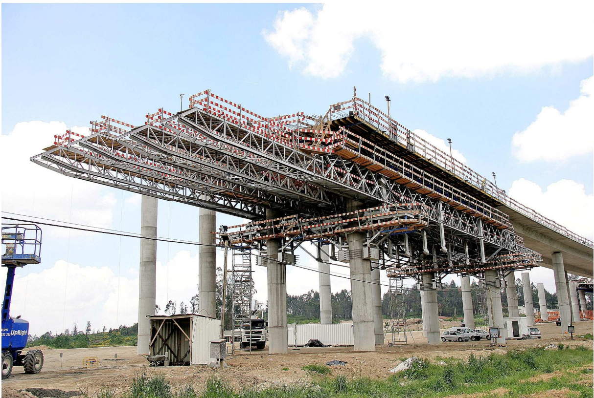
Fig.3.7 – Imagem da construção do tabuleiro da ponte sobre o rio Sousa [7]
