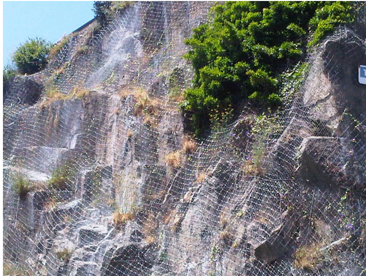
Figura 34 - Exemplo de aplicação de Redes junto á Ponte D.Luís, na cidade do Porto.
