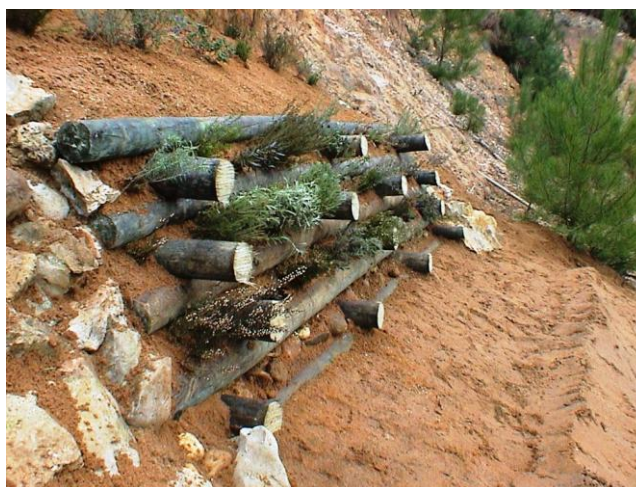
Figura 44 - Intervenção aplicando o muro de suporte vivo. Fonte: (Freitas, 2007).
