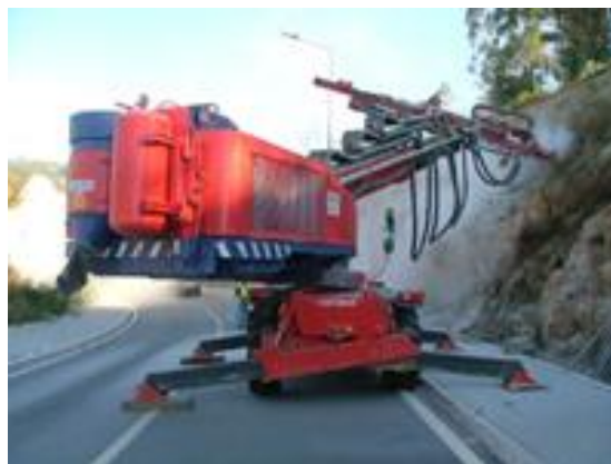
Figura 33 - Máquina que efectua os furos para serem instaladas as Pregagens. Fonte: (Geoprolífero, 2009).
