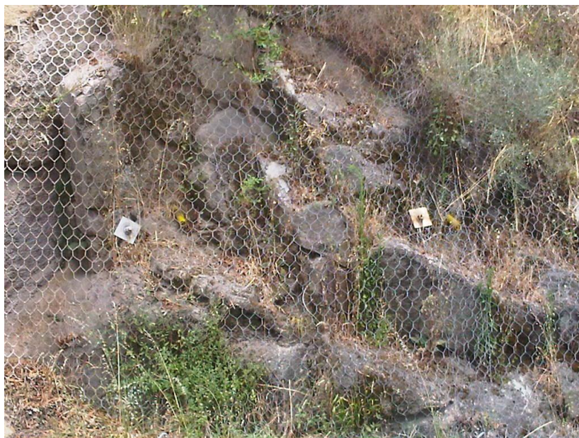
Figura 35 - Exemplo da conjugação de técnicas onde para além dos drenos e de ancoragens se aplica redes, para a estabilização dos taludes.
