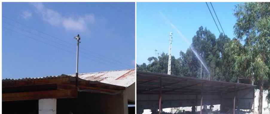
Figura 48 - Aplicação dos aspersores.
