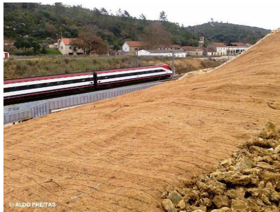
Figura 42 – Aplicação da Manta Orgânica na linha do Norte. Fonte: (Ribeiro, 2008).
