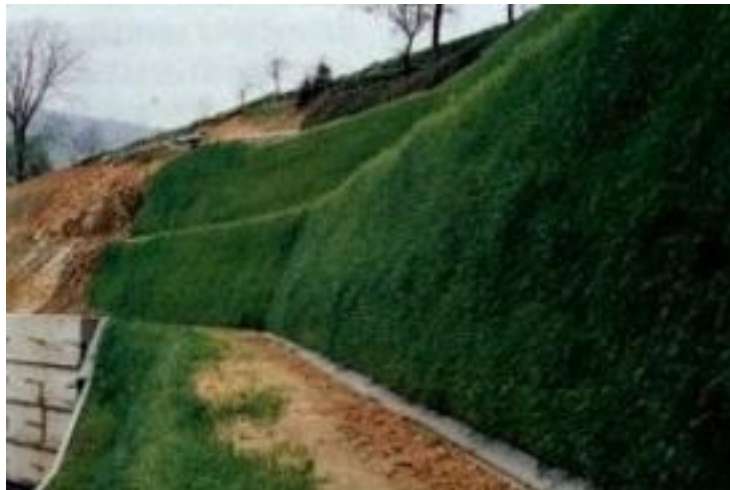
Figura 41 - Resultado da aplicação da Hidrossementeira. Fonte: (HortiRelva, 2010).
