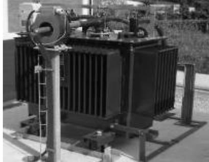
**Figura 2.14** - Ilustração de uma conexão Ground Sensor para Protecção Homopolar de Média Tensão.
