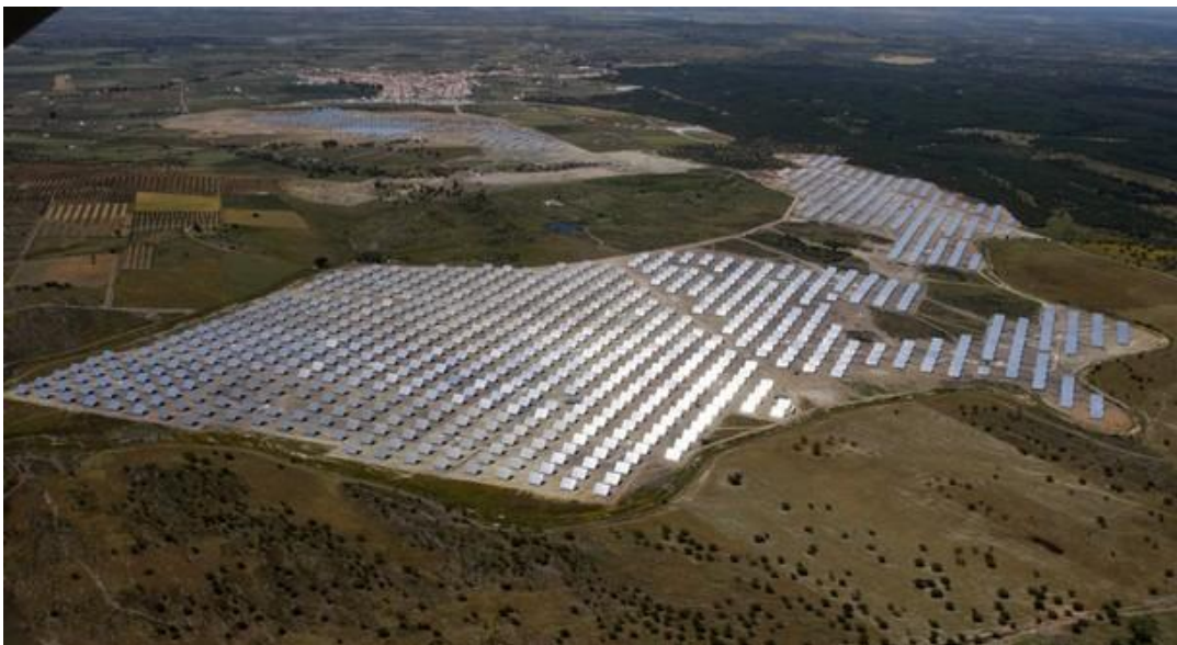
Figura 2.19. Central fotovoltaica de Moura [38]
