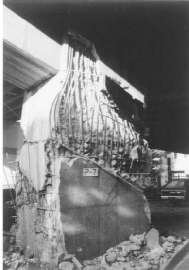
Figura 2.7 – Rotura de pilar no sismo de Kobe (Moehle *et al.* (2000))
