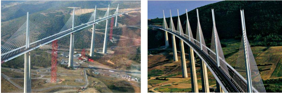
Figura 2.1 – Viaduto de Millau, França ([www.viaducdemillau.com](http://www.viaducdemillau.com) (2009)); Fase de construção (esquerda), Em serviço (direita)
