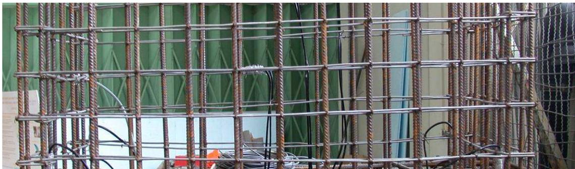
Figura 4.4 – Estribos em arame liso (fotografias em fase de pré-betonagem)
