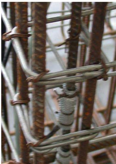
Figura 4.4 – Estribos em arame liso (fotografias em fase de pré-betonagem) (continuação)
