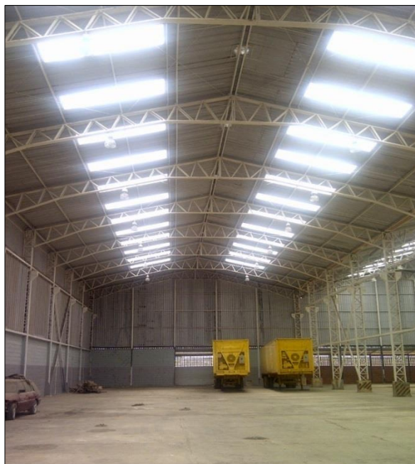
Figura 20 Foto frontal de la parte interna de un galpón
