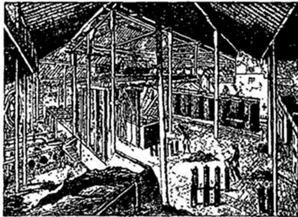
CASA DE CALDERAS DEL INGENIO ASUNCION.
