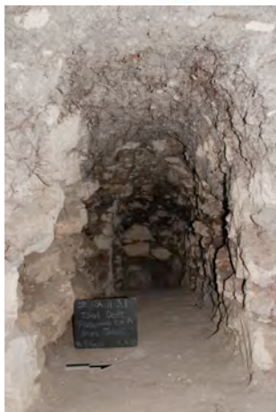
Figura 4: Vista del túnel en la plataforma de sustentación de la Estructura A
