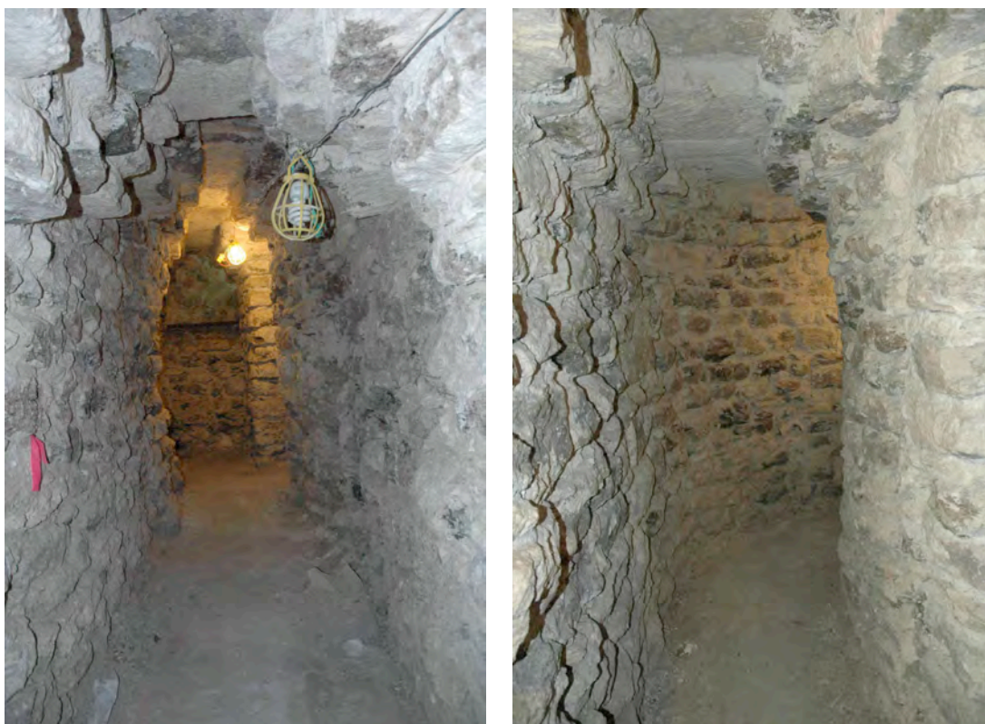
Izquierda: Figura 7. Túnel central en Sub 1A, vista hacia la ventana 2 del muro oeste.
