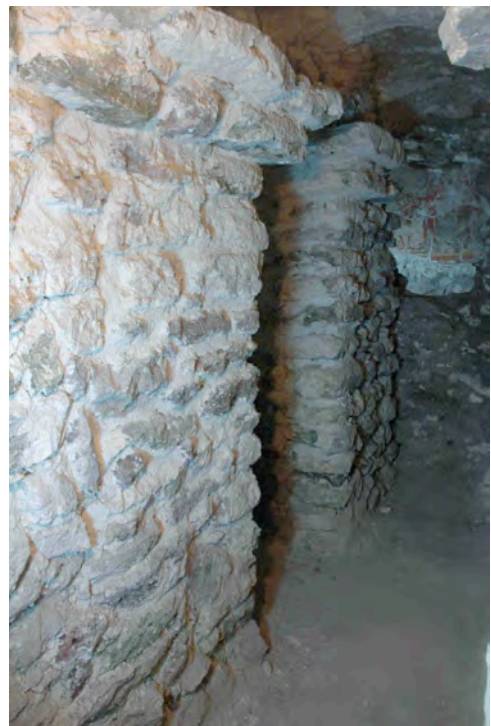
Figura 6. Túnel norte y ventana 4.
