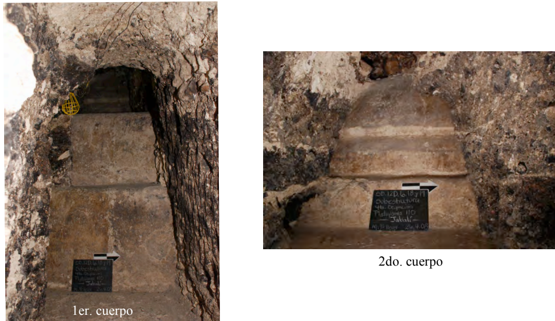
Figura 3: Vistas de la Subestructura de la 4ta. etapa constructiva
