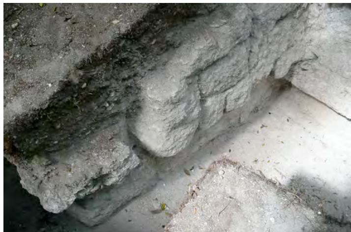
Esquina remetida noreste de la Estructura 136
