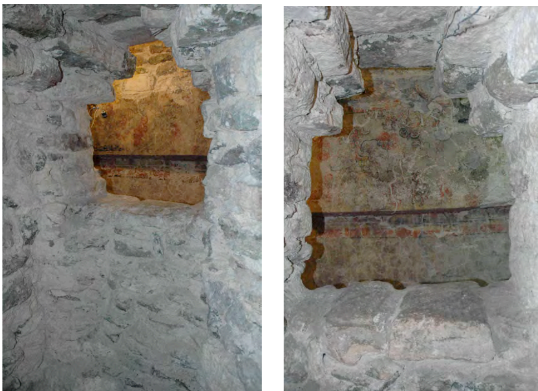
Izquierda: Figura 2. Ventana 1, vista al extremo sur del muro oeste. Derecha: Figura 3. Ventana 2 o central, vista hacia el muro oeste.
