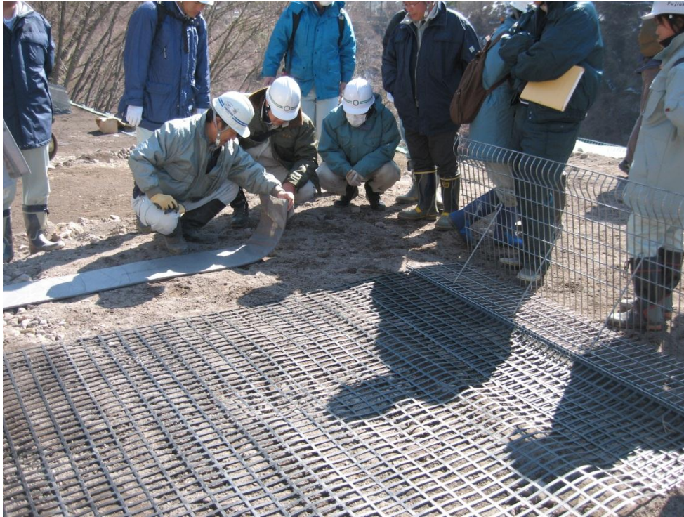
写真 4-2 補強土工の現場での研修
