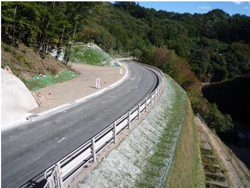
写真 6-7 完成直前(平成 23 年 10 月)
