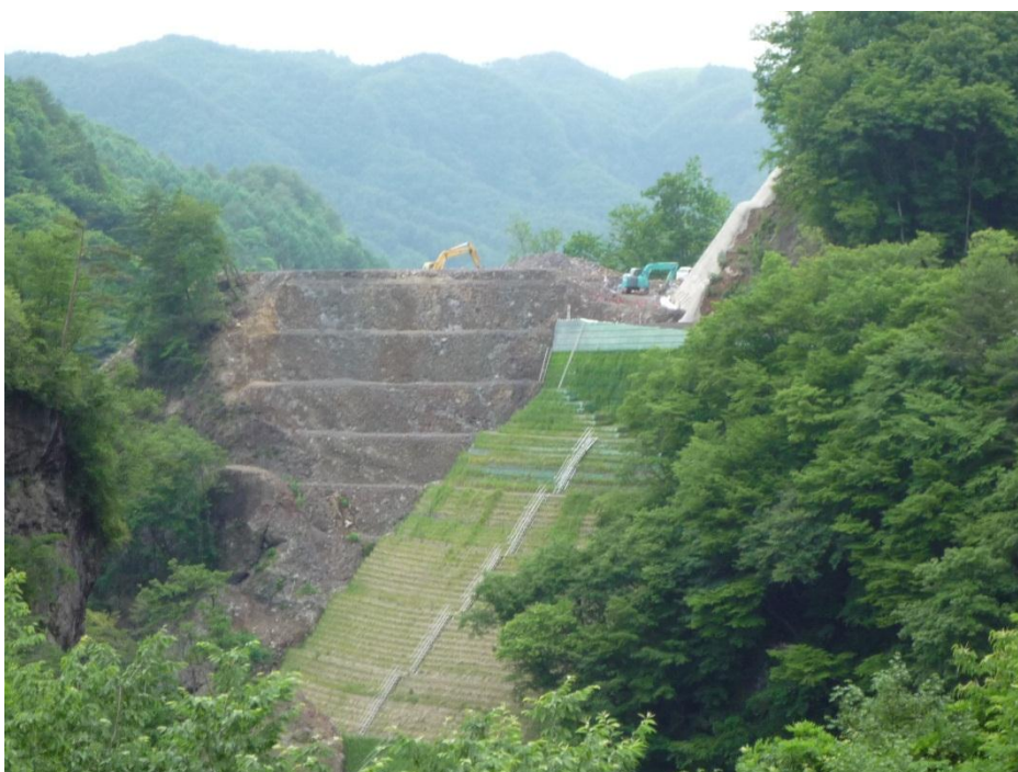
写真 6-5 完成間近の高盛土構造物(平成 23 年 6 月)
