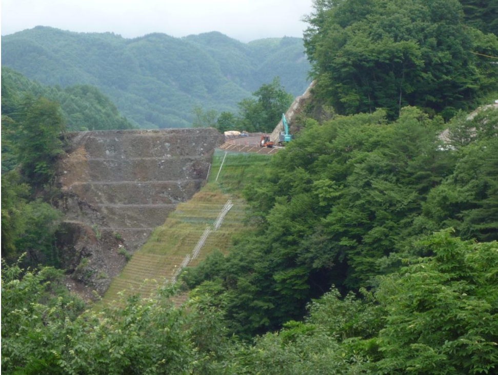
写真 6-6 完成間近の高盛土構造物(平成 23 年 8 月)
