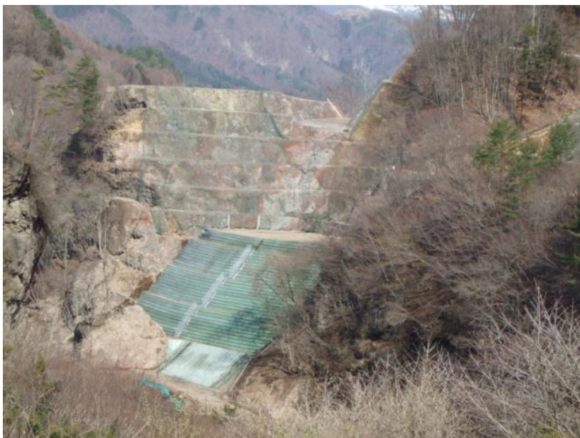
写真 6-3 補強盛土施工中
