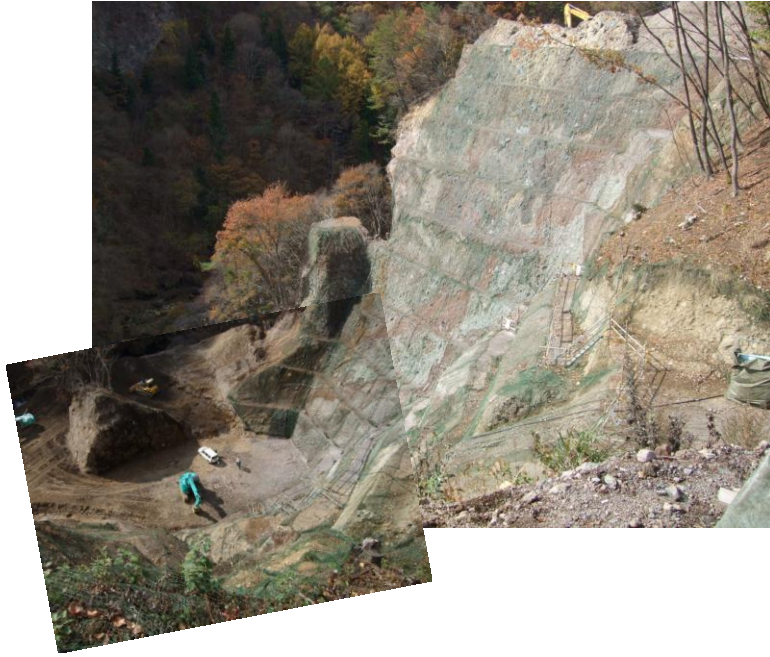
写真 6-2 掘削完了(平成 21 年 11 月)
