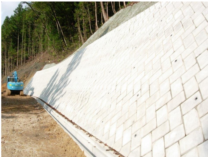
写真 5-3 完成したブロック積み擁壁
