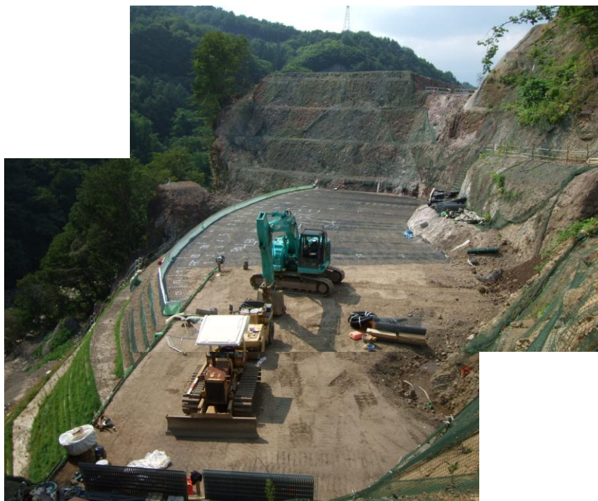
写真 6-4 補強盛土施工中(平成 22 年 8 月)
