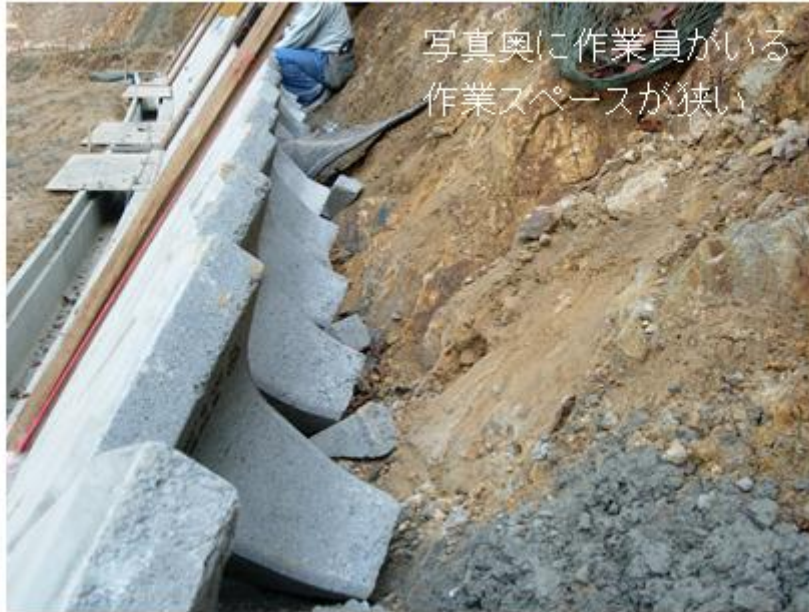
写真 5-2 ブロック積み施工状況
