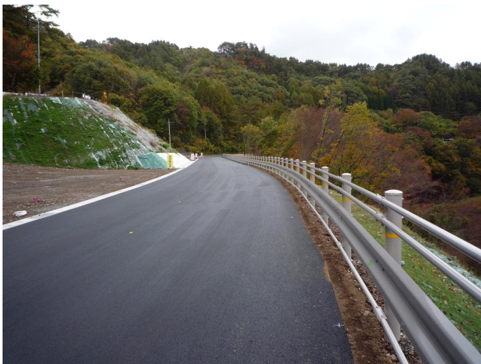
写真 6-8 完成（平成 23 年 10 月）
