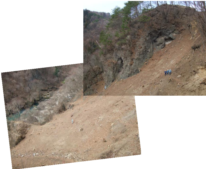
写真 6-1 着工前(左が白砂川) (平成 21 年 4 月)
