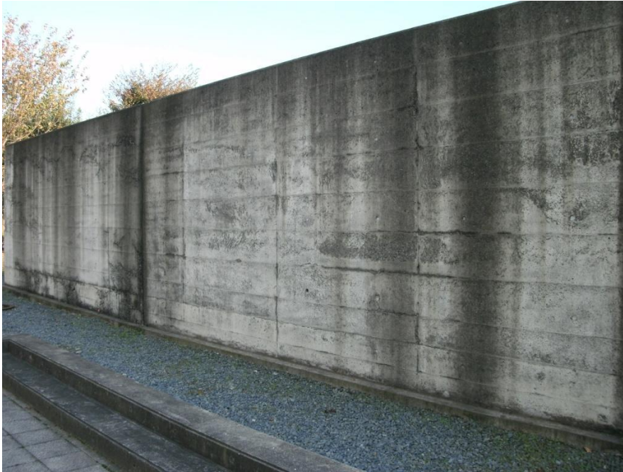
写真 4-6 擁壁施工例（実物大）
