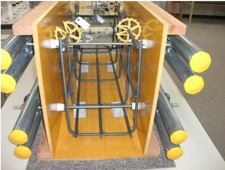
写真 4-5 鉄筋コンクリート構造物の配筋及び型枠組立（実物大）
