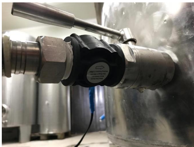
Slika 5.3: Senzor pretoka, nameščen na cisterno
