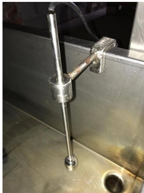
Slika 3.3: a) NE vrat s tranzistorji, b) Plovec, nameščen na krnico
