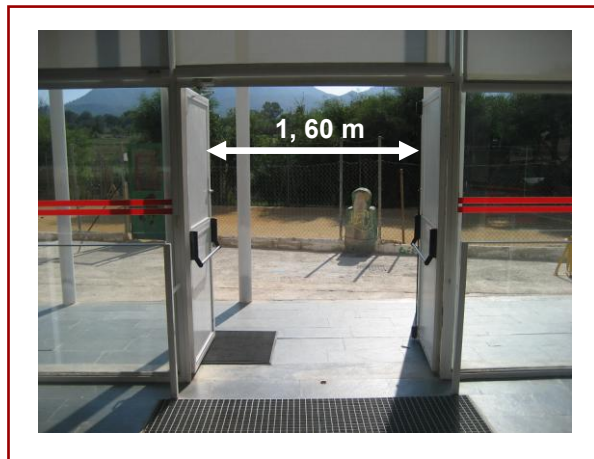
FIGURA 4. Puerta de salida al exterior, de un pabellón polideportivo de uso escolar.
