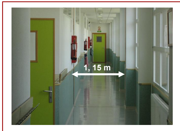
FIGURA 5. Pasillo (vía de circulación) de acceso a instalaciones deportivas.
