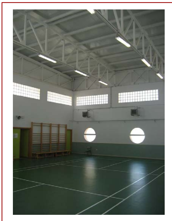
FIGURA 30. Ejemplo de iluminación, en un pabellón polideportivo escolar de centro público, donde se combinan la luz natural y la artificial.
