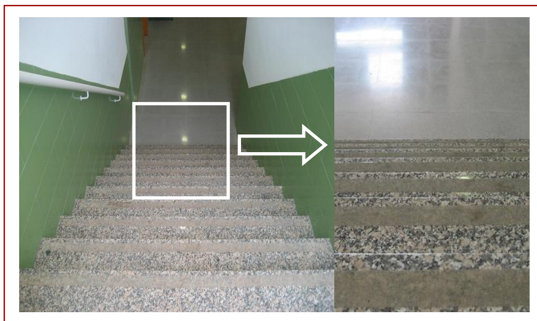
FIGURA 3. Detalle de escalones con instalación de bandas antideslizantes.
