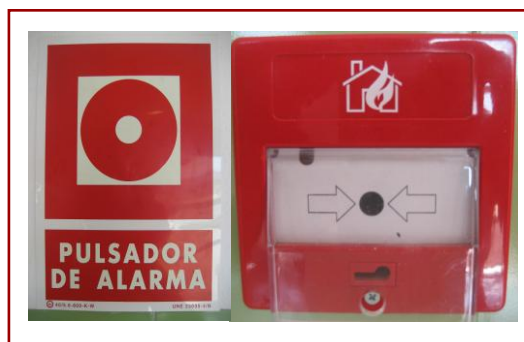
FIGURA 18. Señalización y pulsador de emergencia contra incendios, en centro concertado.
