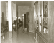
Positas. Estado de las instalaciones tras las inundaciones de octubre de 1973.
