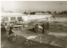
Reparación de las instalaciones una semana después. Inundaciones de octubre de 1973.
